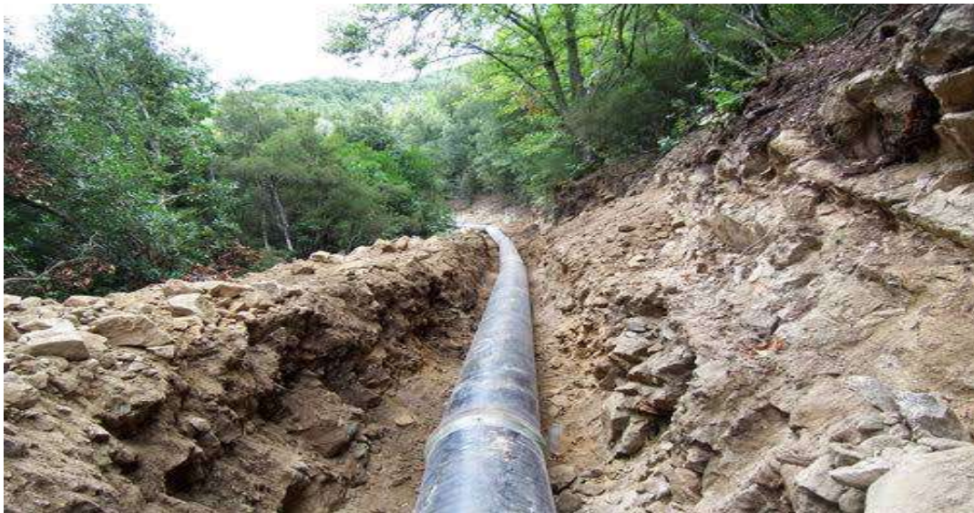
Figure (V.1) : Pose des conduites en terre.
