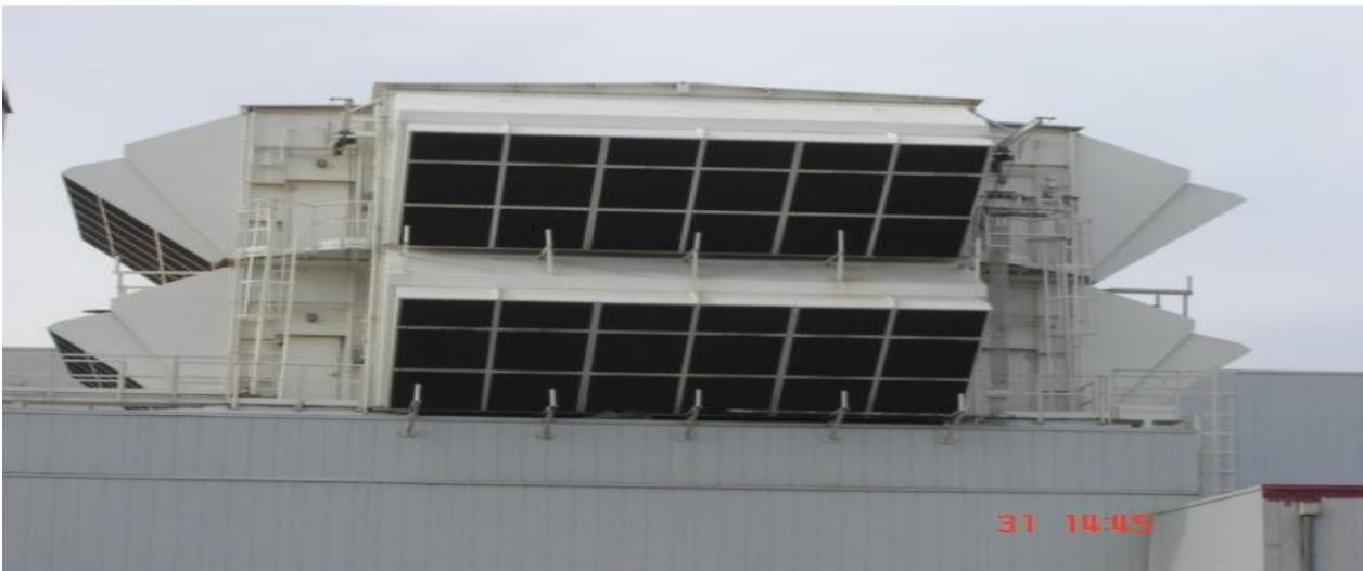
**Figure II.4.Vue externe du système d'aspiration d'air et de filtration**
