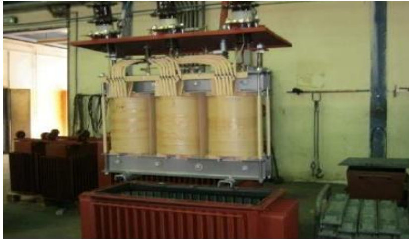
Figure 2-7 : Encuvage des parties active du transformateur.
