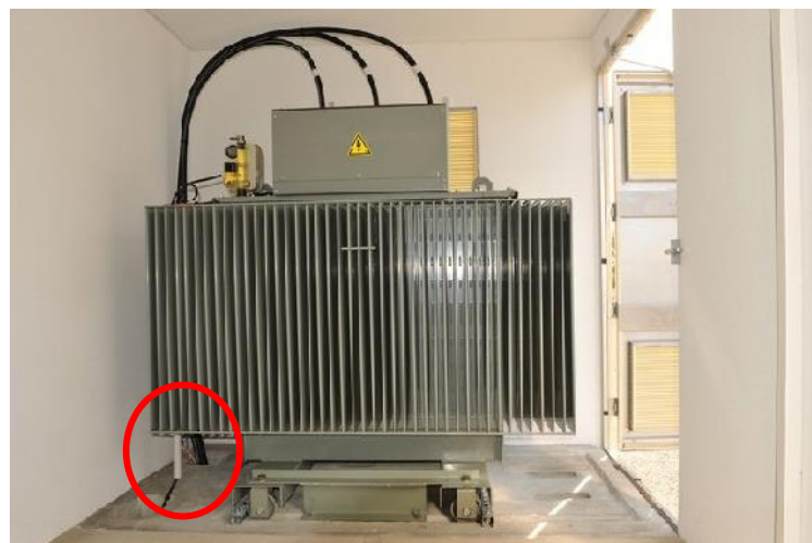
Figure 2-8 : Remplissage du transformateur.
