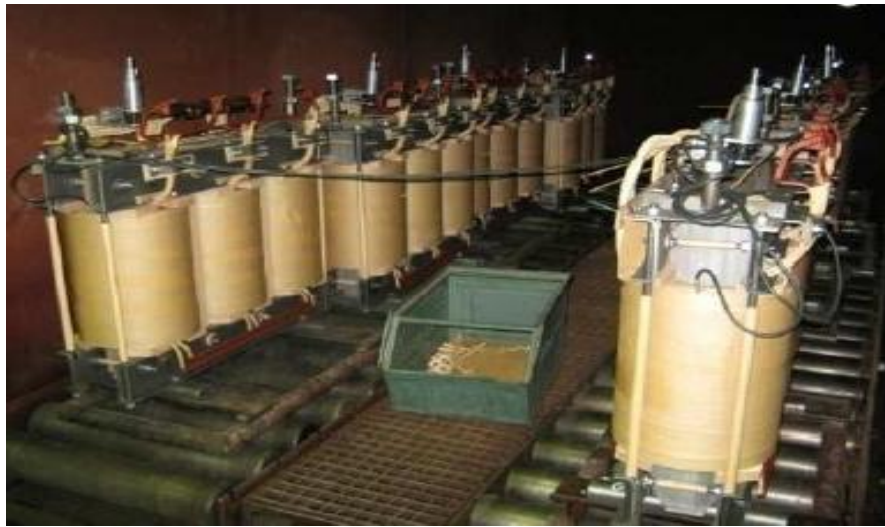
Figure 2-6 : séchage des parties active du transformateur.
