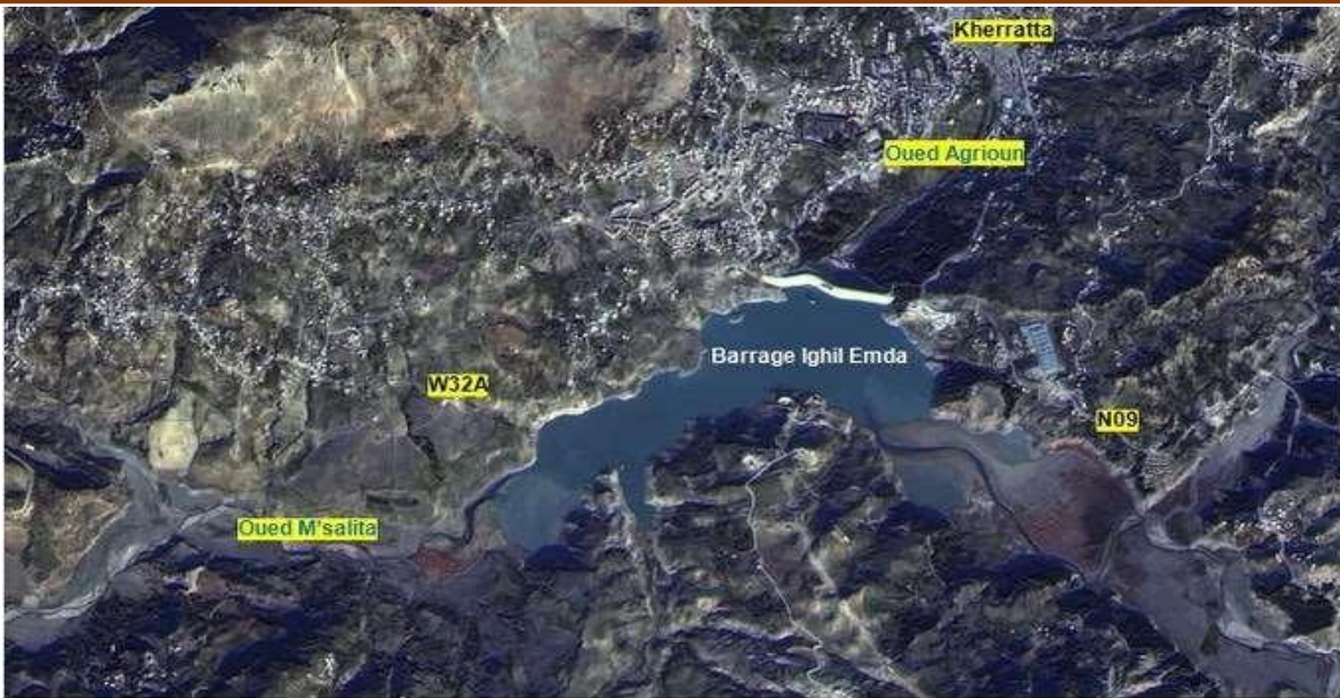
Figure I.8 : image satellite de la retenue d'Ighil-Emda (source- Google Earth)
