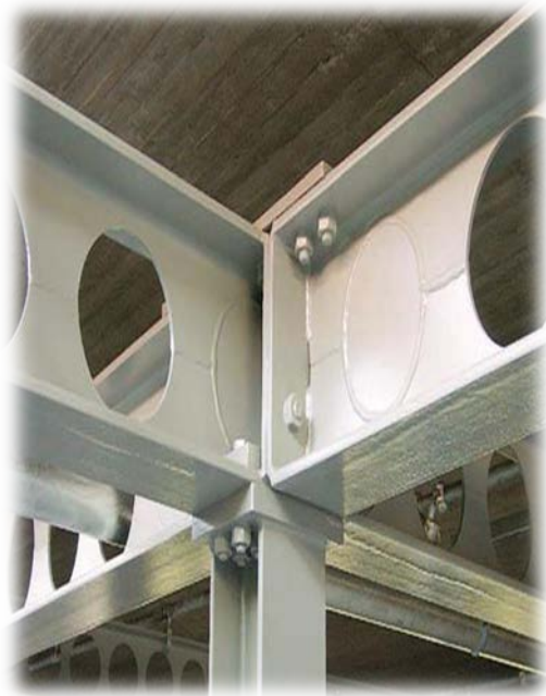
Assemblage poteau poutre par boulonnage
