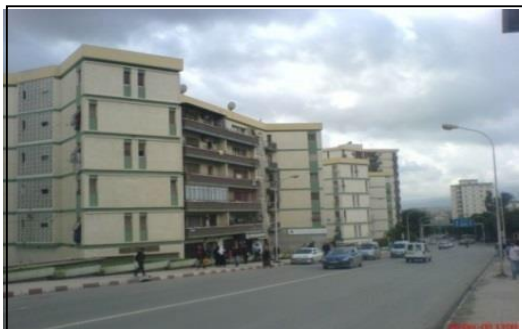
Fig.122. Façades Avant la réhabilitation Source : auteurs.
