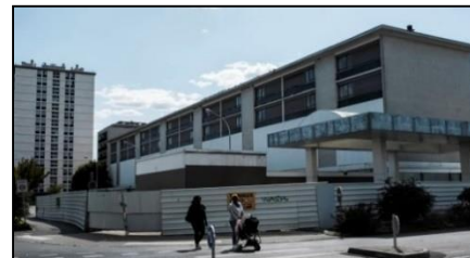
Fig.66. L'état actuel du bâti Source : Google
