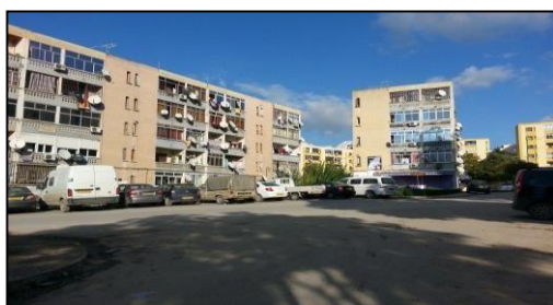
Fig.116. Façades Avant la réhabilitation Source : auteurs.
