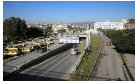
Fig.35. la trémie actuellement source : auteurs
