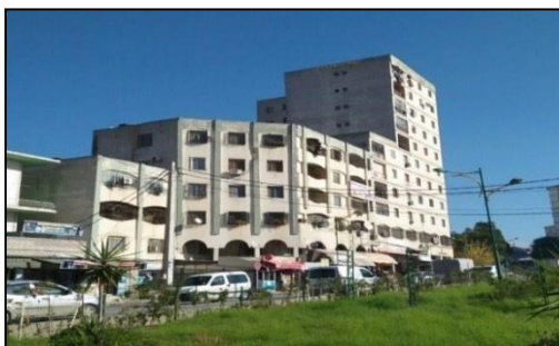
Fig.119. Façades Avant la réhabilitation Source : auteurs.
