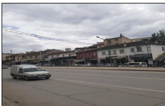
Fig.125. L'état actuel des maisons individuelles Source : auteurs.
