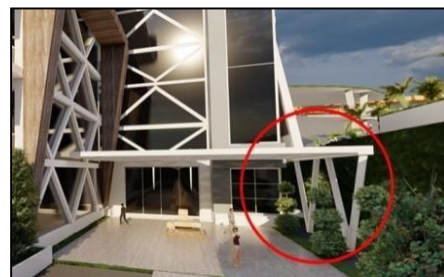
Fig.227. Poteau x inclinés pour tenir la couverture de l'accès VIP Source : auteurs
