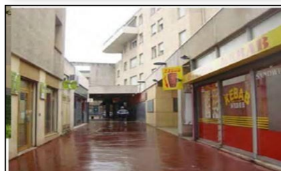
Fig.80. L'état actuel du bâti source : Google.
