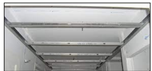
Fig.240. faux plafond en Placoplatre Source : https://faux-plafond.net
