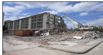
Fig.67. L'état actuel du bâti Source : Google
