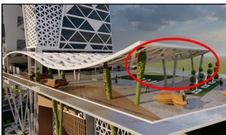
Fig.226. Poteau x inclinés pour tenir la terrasse et la couverture Source : auteurs
