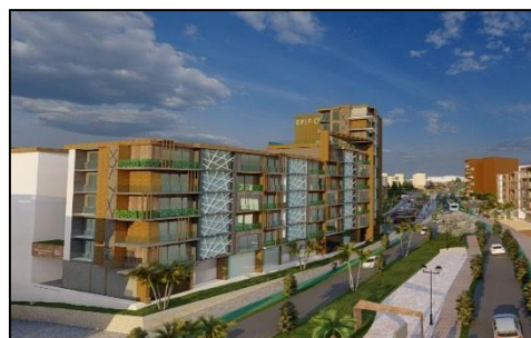
Fig.120. Façades après la réhabilitation Source : auteurs.
