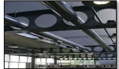
Fig.228. Poutres alvéolaires Source : www.GenieCivilPDF.com
