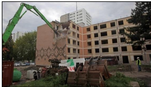
Fig.94. L'état actuel du bâti source : Google.
