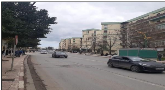
Fig.104. L'Etat actuel de la voie Source : auteurs
