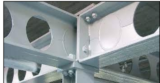
Fig.233. Assemblage poteau métallique poutre alvéolée Source : www.constructionmetallique.fr
