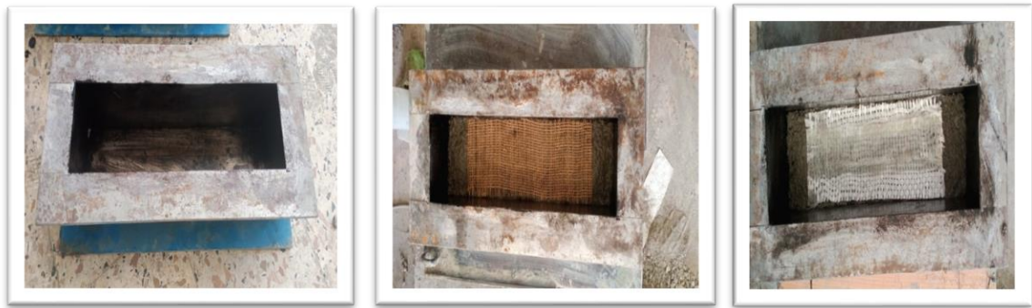
Figure II.10 : Mise en place des renfort
