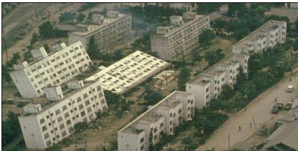
Figure II.7. Sol liquéfié entraînant l'inclinaison, voire le renversement, des bâtiments
