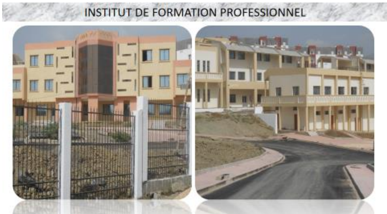
Photo n° 6 : Institut professionnel achevé au quartier AADL Prise le 30/09/2020
