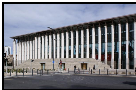
Fig. 27: Nouvelle gare saint Charles.
