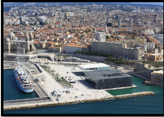
Nouvelle gare maritime.
