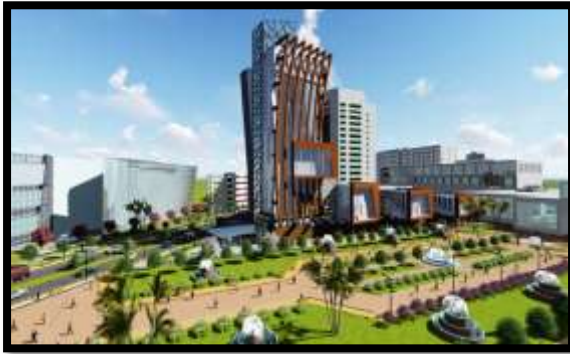
Fig.28 : Vue sur la façade de l'entité formation. Source : Auteurs.
