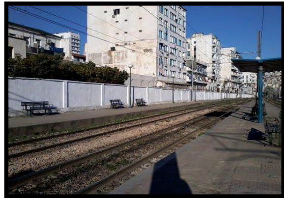
Fig. 29 : photo montrant la voie ferrée.
