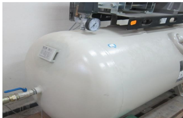
Figure(III.2): Vanne en position ouverte
