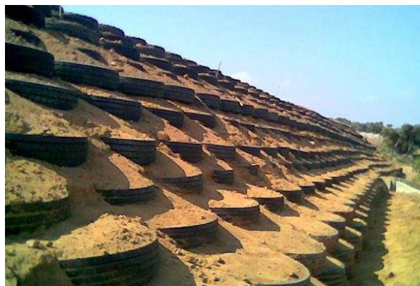
Figure I.30. Chantier expérimental Pneusol à Bou-Smail
