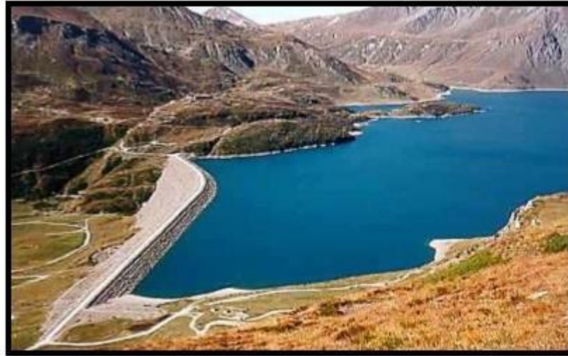
Figure I.7 : Barrage en terre
