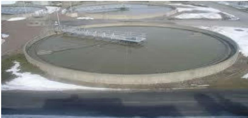
**Figure VI.6 : décanteur secondaire (clarificateur)**
