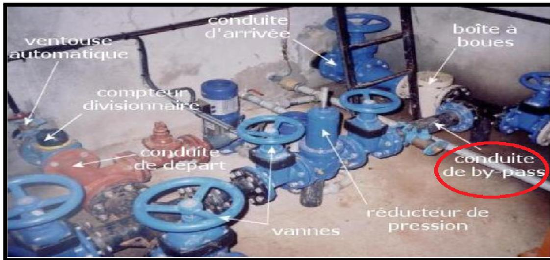
**Figure VII-5) : La conduite de by-pass**
