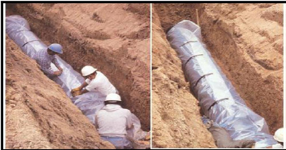
**Figure VI-16) : Protection contre la corrosion extérieure avec revêtement en polyéthylène.**
