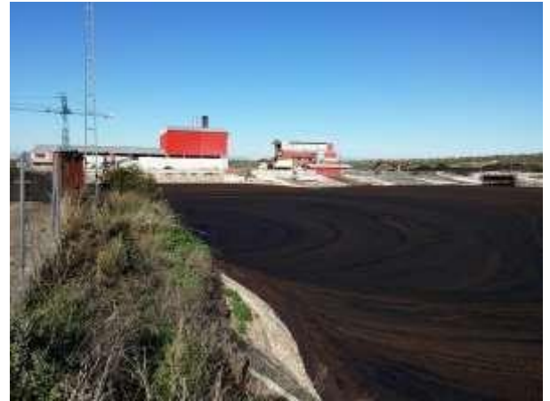
Figure.6 Bassin de récolte des margines d'une usine d'extraction d'huile d'olive (2015).
