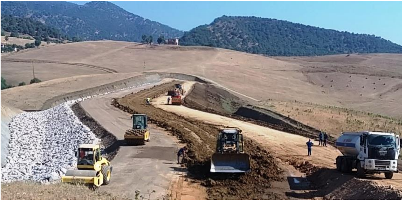
Digue de col
