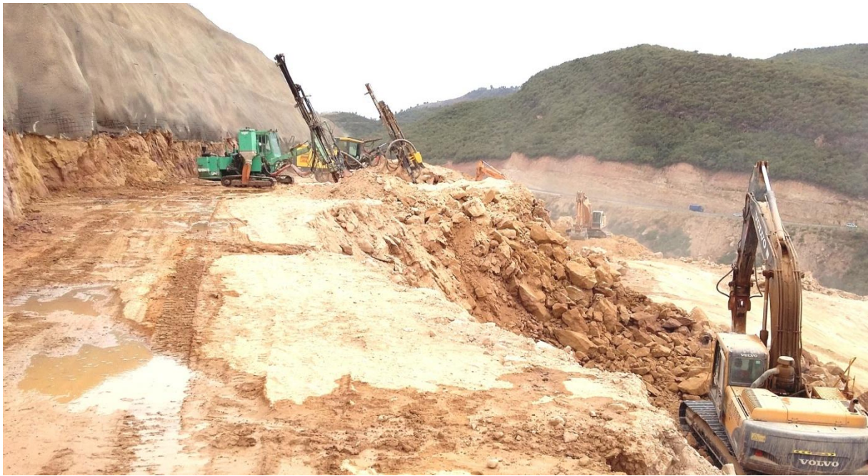
Forage pour explosif à l'évacuateur de crues
