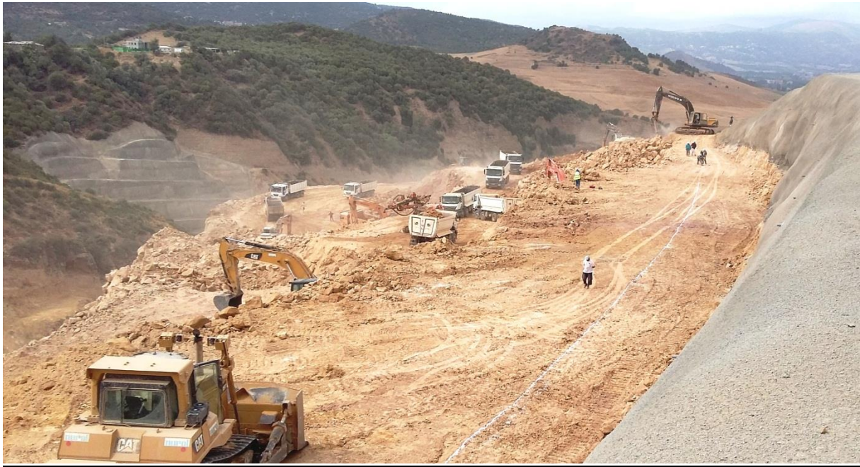
Evacuateur de crues
