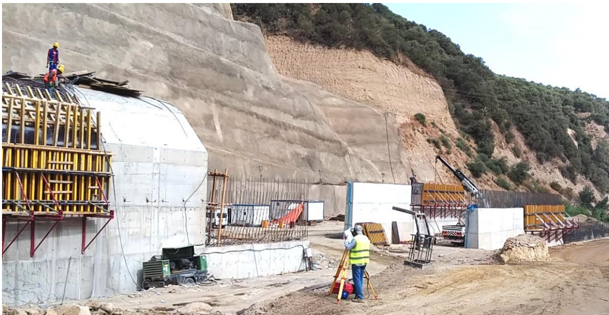
Sortie avale de la galerie DP1
