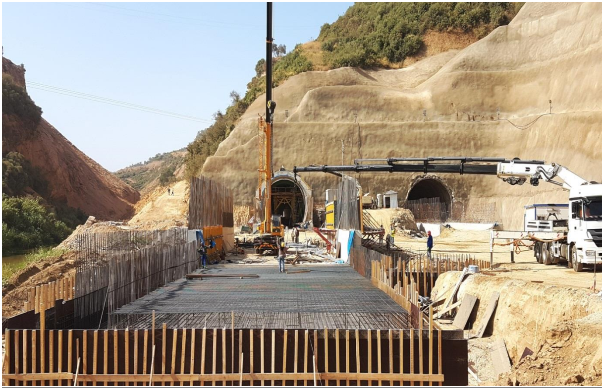
Portail aval et sortie des galeries de dérivation provisoires
