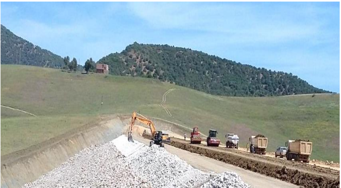
Mise des remblais à la digue de col
