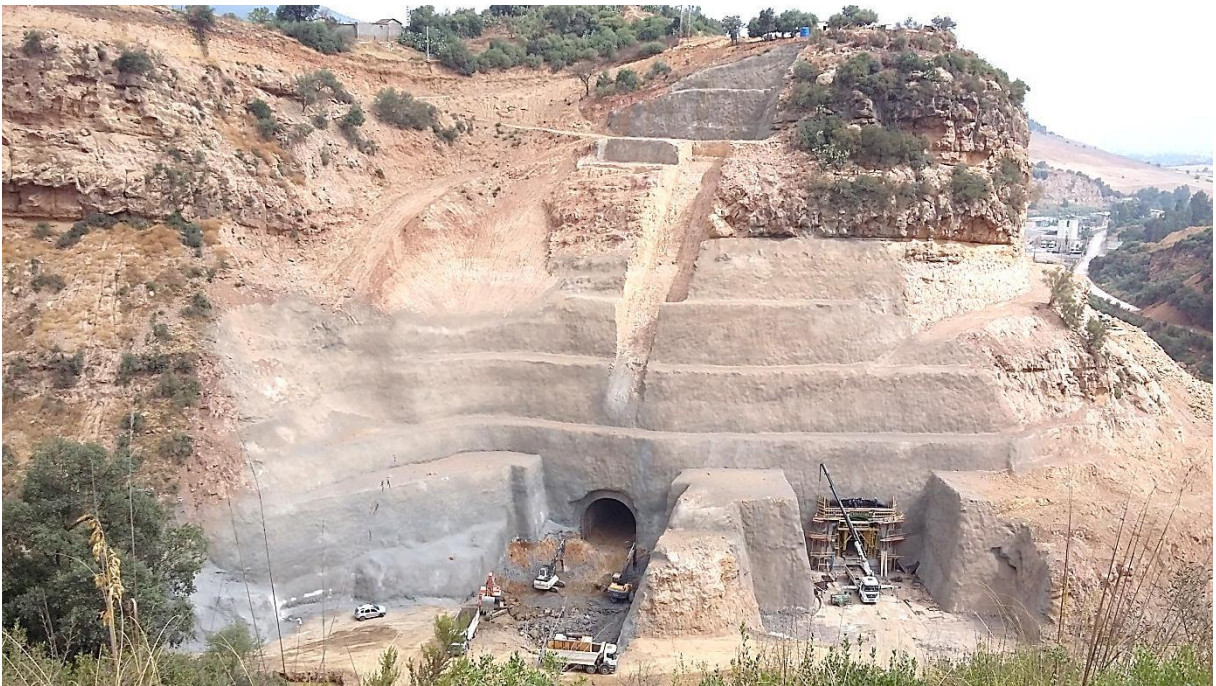
Portail amont et Sortie des galeries de dérivations provisoires
