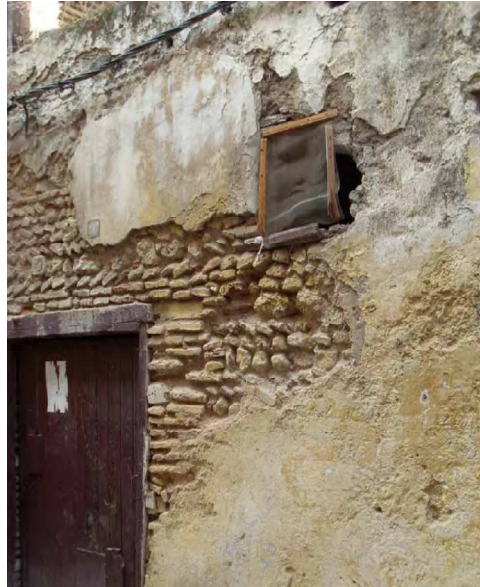
Figure III.8 Détail d'un mur à moellons, Source Atif.S
