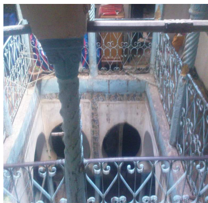
Figure V.11: Vue sur Patio, Source : Auteur
