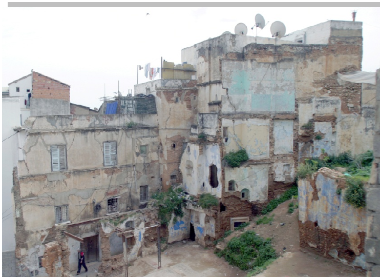
Figure VI.16: Casbah d'Alger en ruine, Source Auteur
