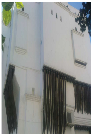
Figure V.13 Vue sur encorbellement Source auteur
