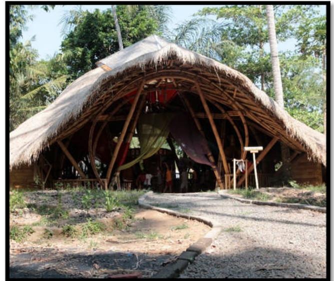
Figure II.16 : le bambou utilisé pour la construction de l'école
