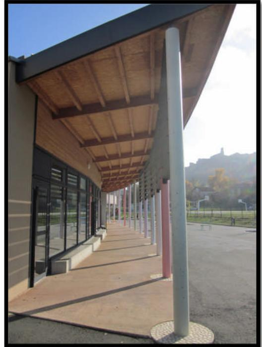
**La façade Nord** (en béton avec isolation par l'extérieur) est réduite en surface et comprend peu d'ouvertures afin de limiter les déperditions de chaleur (les locaux à utilisation intermittente ont été disposés de ce côté, et servent d'espace tampon).
