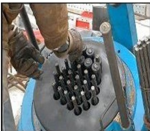
Figure I-16 : Mise en tension des câbles de précontrainte.
