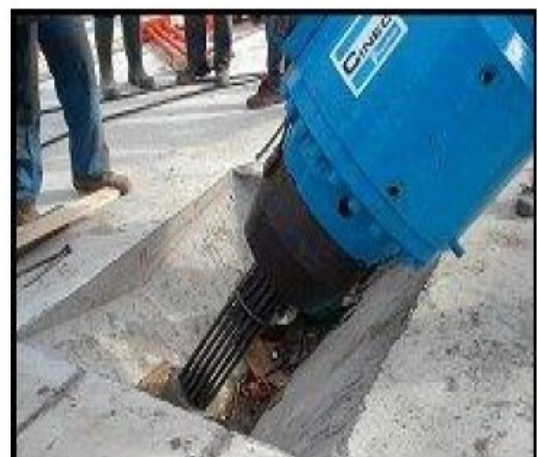
Figure I-16 : Mise en tension des câbles de précontrainte.
