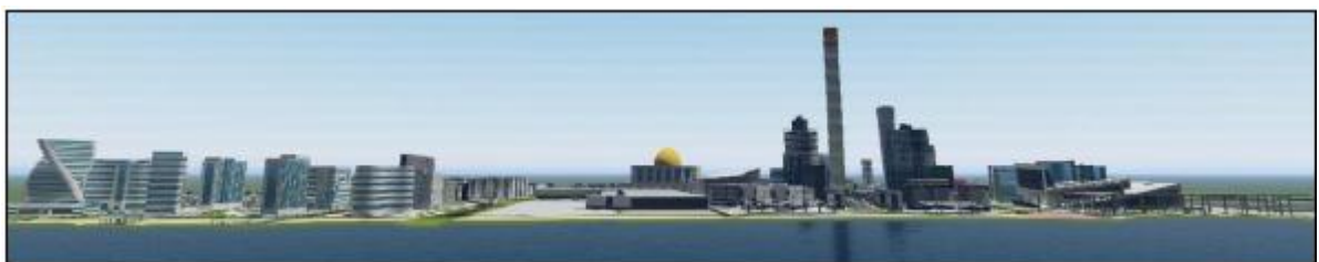
Figure 70 : Ensemble de l'opération Urbaine.
