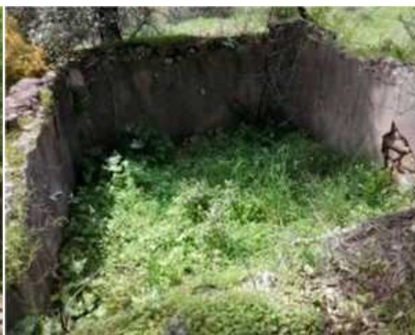
Photo N°12 : un bassin vide.
