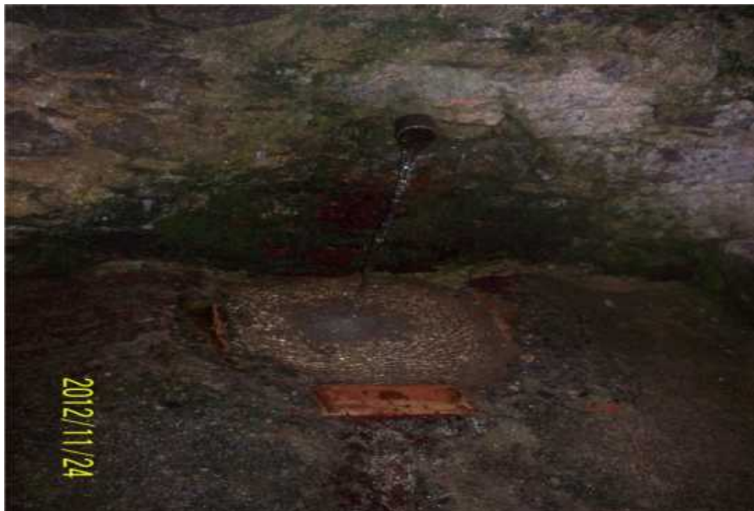
Photo N°42 : Tala de Bozehrir
