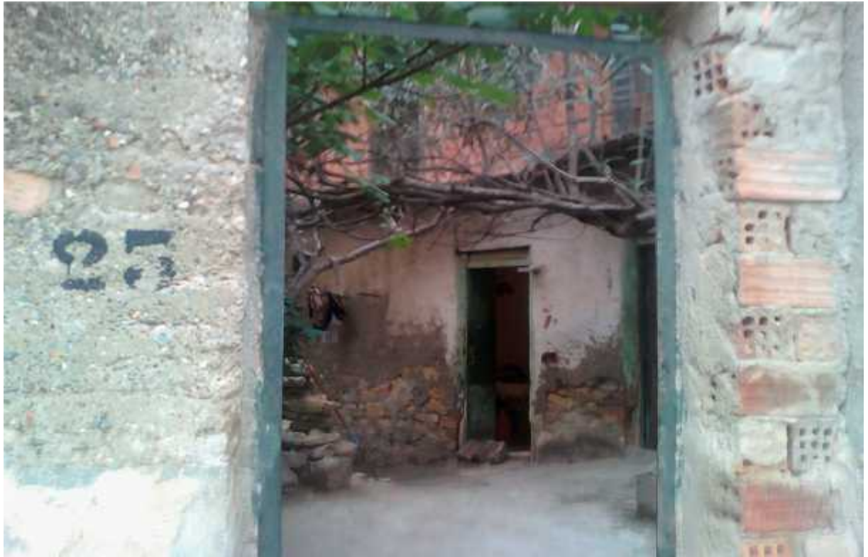
- Photo N°47 : La maison d'el-Mesloub par l'extérieur.
