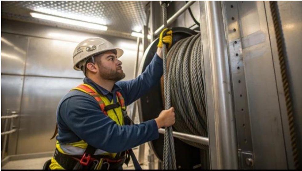
Figure IV.2 : Exemple d'intervention de maintenance préventive : lubrification des câbles de traction.
