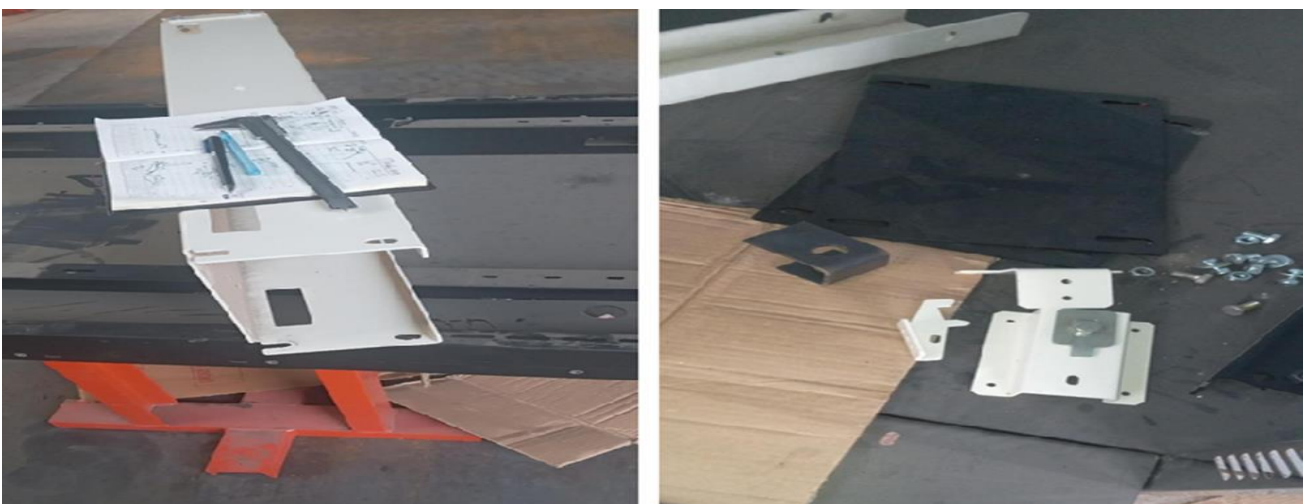
Figure II.3: Démontage de l'arcade d'ascenseur.
