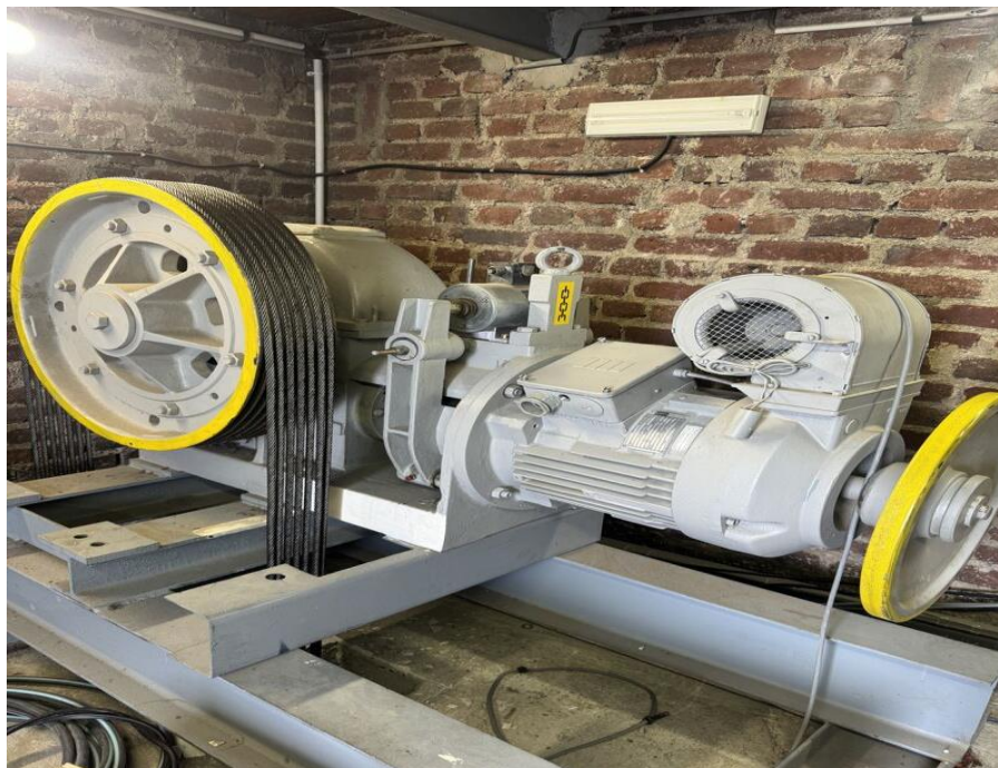
Figure I.12: Moteur-treuil à vis sans fin.
