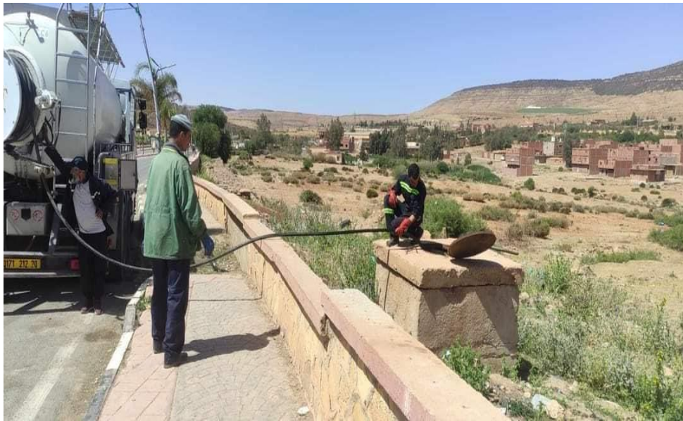
Figure 18 : participation de l'ONA au nettoyage des réseaux d'assainissement
