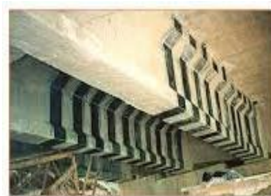
Figure 14: Renforcement au cisaillement avec PRF de carbone.
