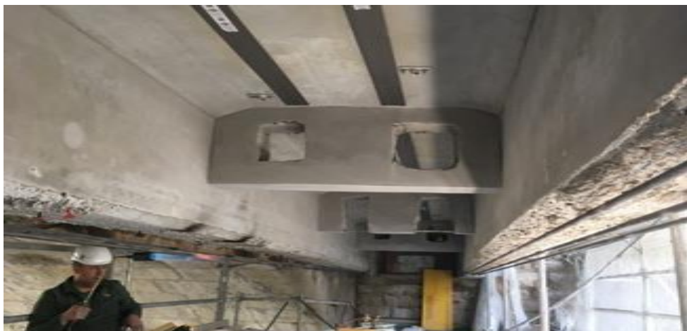
Figure 13 : Renforcement en flexion avec un PRF de carbone.
