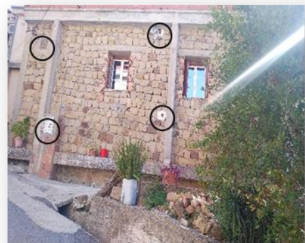
Figure 24: maison rénovée Source : Auteurs 03/11/2022
