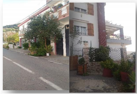
Figure 23: construction modernes à AZRA Source : Auteurs 03/11/2022
