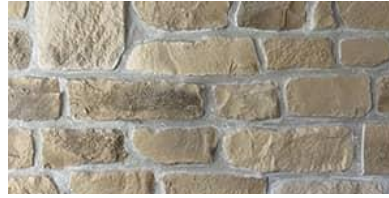
Figure 82: pose avec joints
