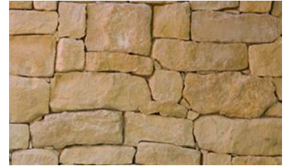
Figure 83: pose en pierre sèche
