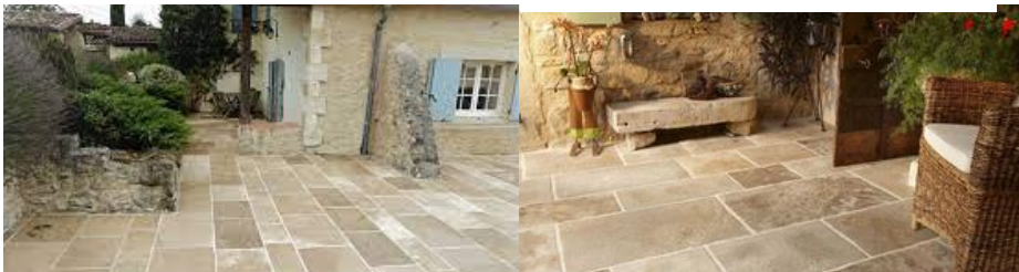
Figure 88: revêtement du sol : extérieur et intérieur
