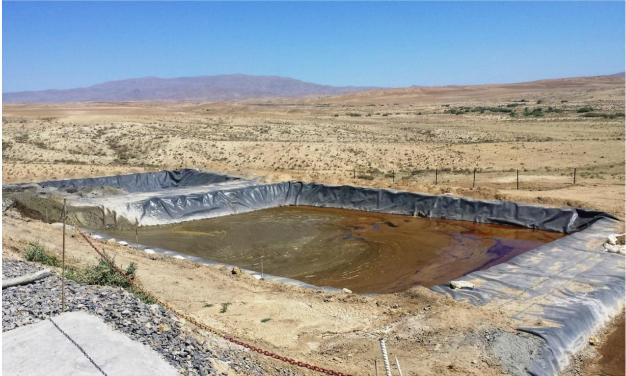
**Figure n°6 :** Site de stockage des boues de forage (bourbier) Tp206 SIDI AISSA.
