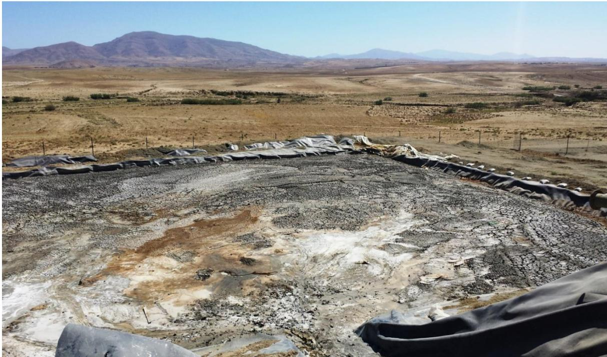
**Figure n°18** : bourbier saturé après traitement et séchage TP206
