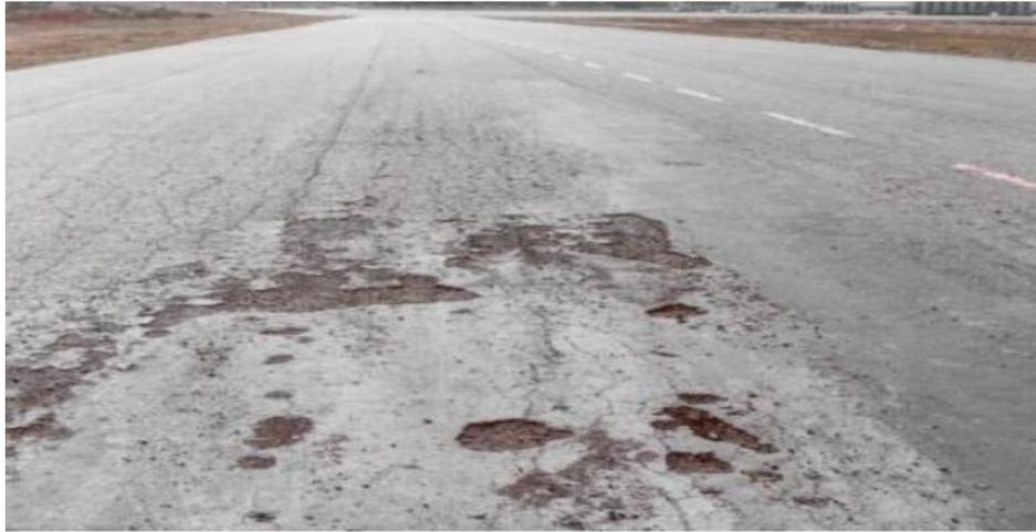
Figure I.9: Dégradation d'arrachement.
