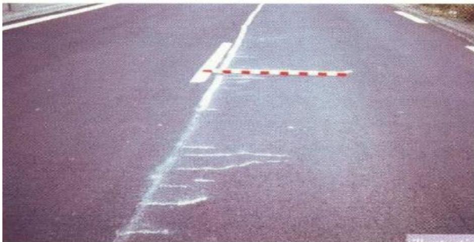
Figure I.10: Remonté des fines: dégradation franche, significative et étendue (LCPC, 1998).
