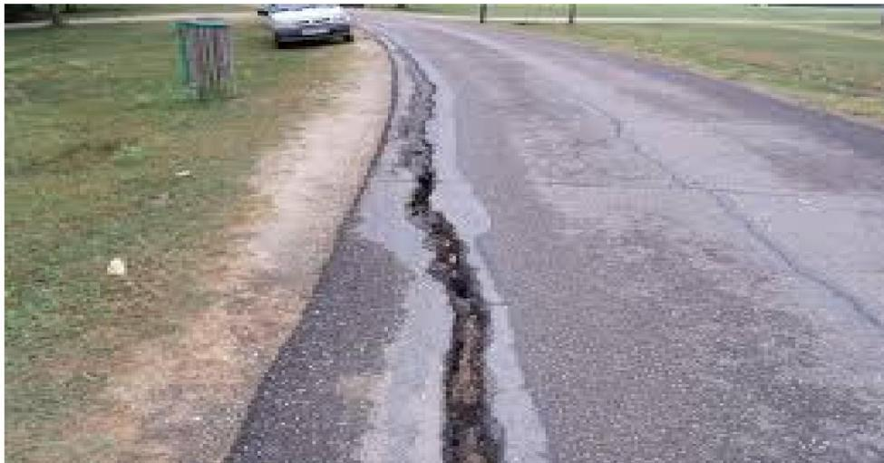
Figure I.12 : Fissures dans une chaussée.
