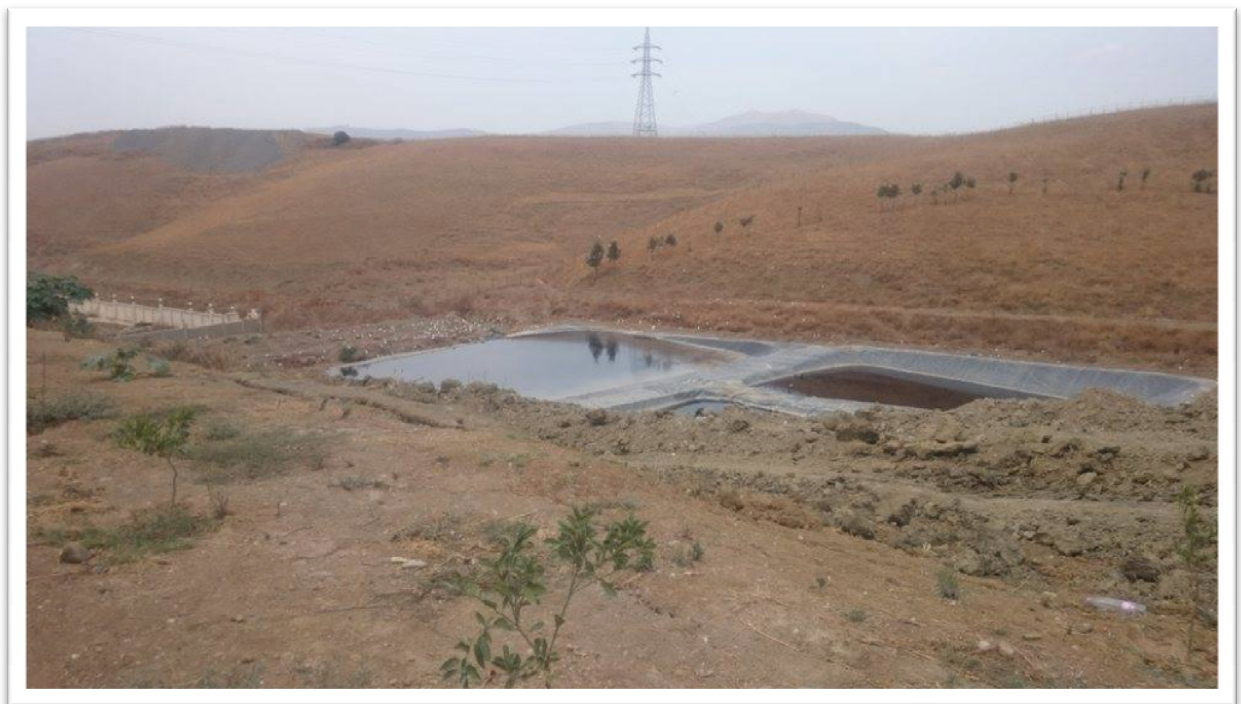
Figure 27 : État du bassin de lixiviat du CET d'Oued falli (original 2016)
