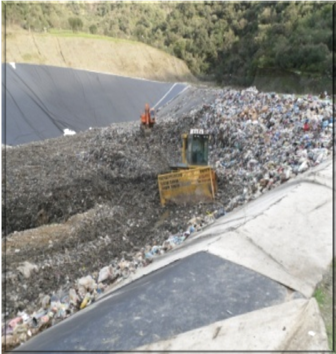
Figure 10: Opération d'épandage dans le casier
