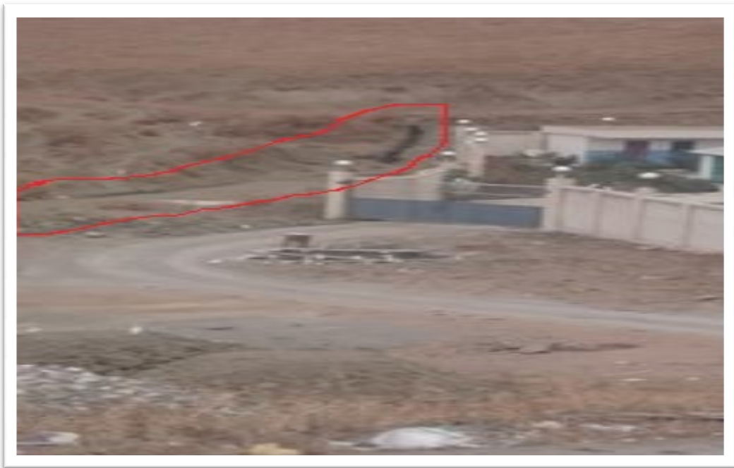
Figure 28: Raccordement du dispositif de drainage de lixiviat du CET d'Oued falli au réseau d'assainissement (original 2016)
