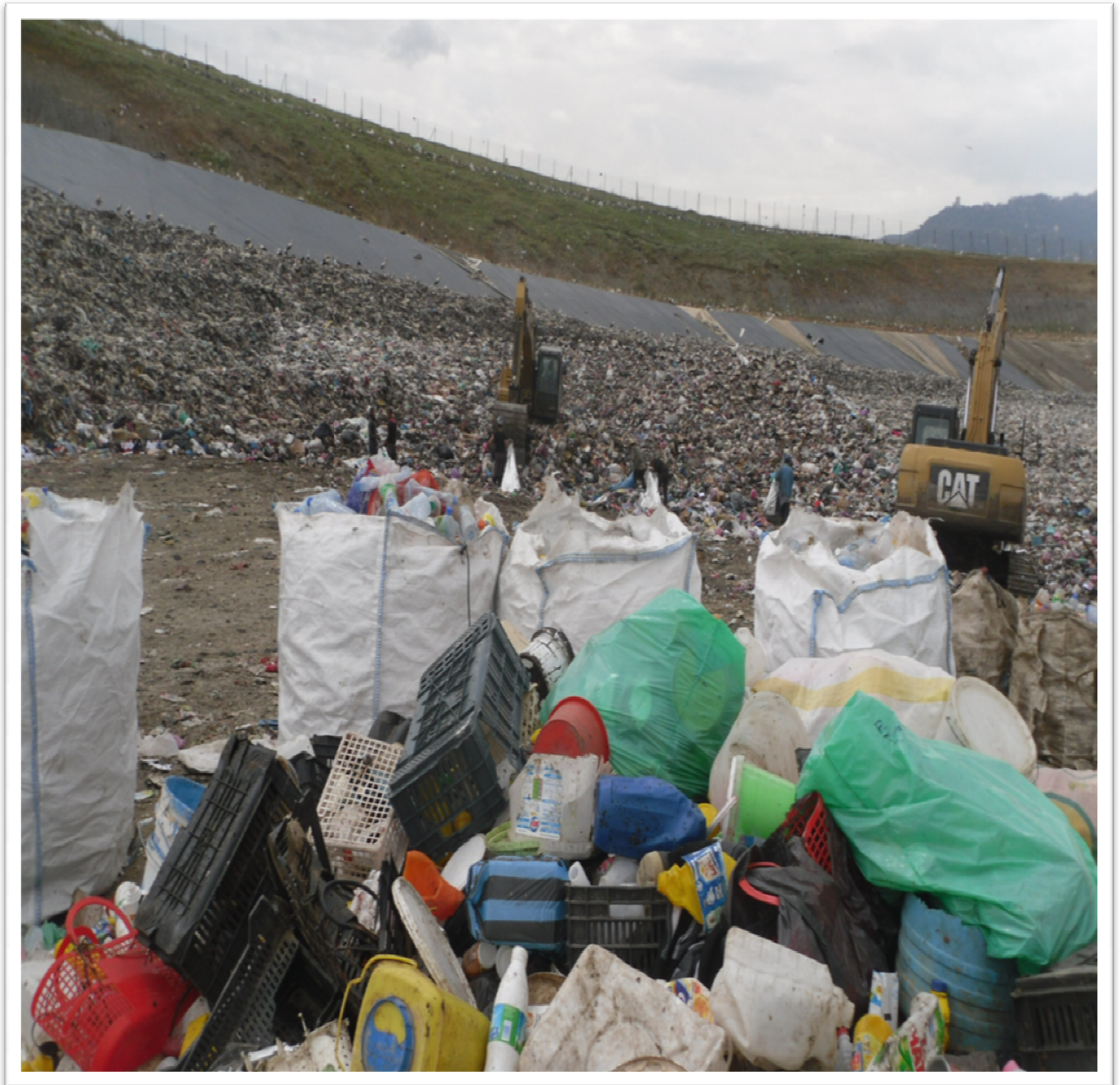
Figure 26 : Ouvriers récupérant les fractions recyclables sur un casier en cours d'exploitation (original 2016)
