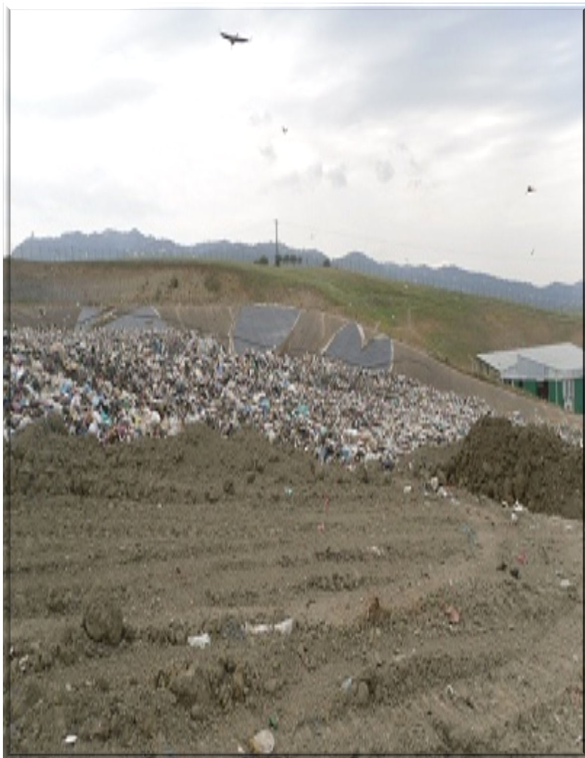
Figure11: Opération de recouvrement par terre végétative
