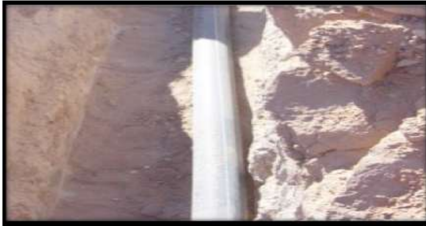
Figure 7.1 : pose des conduites en terre
