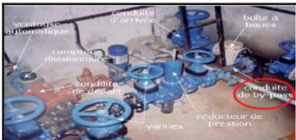
Figure 4.4 : la conduite by-pass
