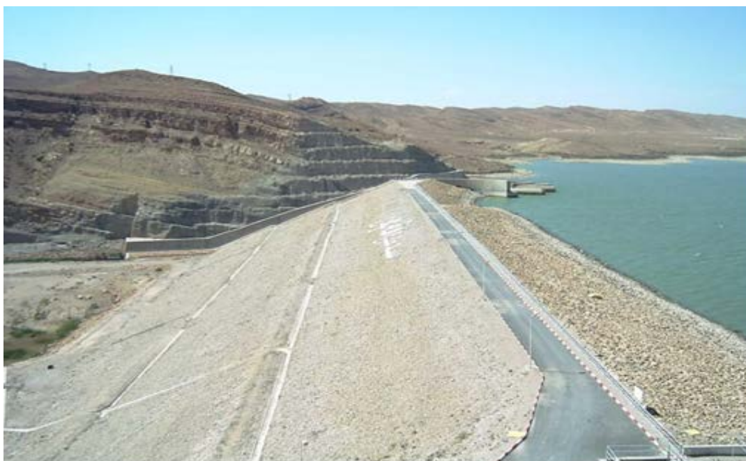
Figure VI.1: Evacuateur latéral a entonnement frontal
