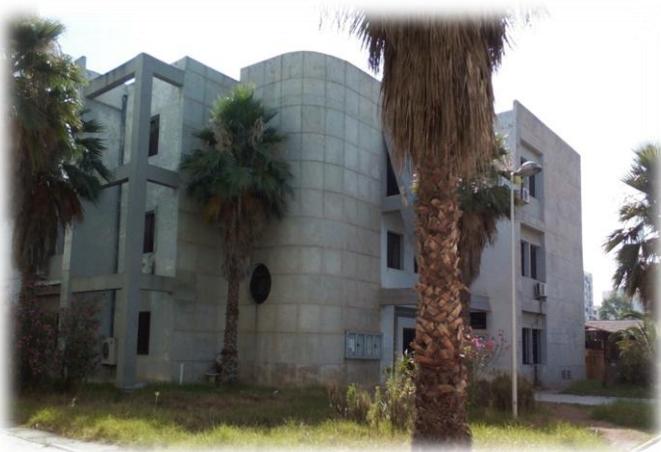
Salles des travaux
