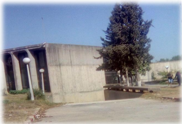
Entrée sous sol
