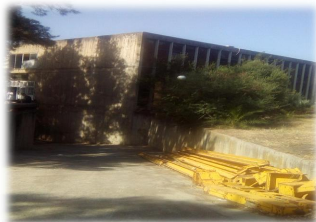
Entrée sous sol
