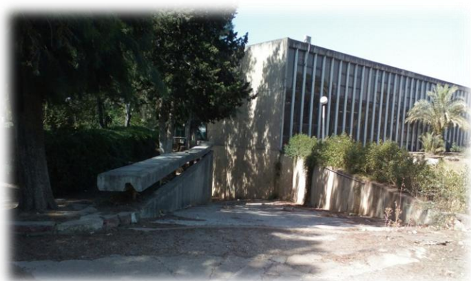
Entrée sous sol
