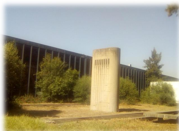
Tour de chauffage
