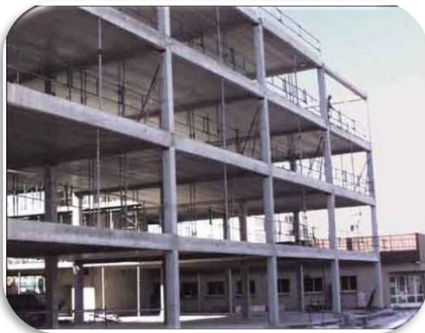
Structure poteaux poutres-dalles
