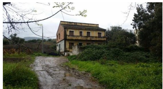
Fig. I. 56 : Vue dégagée sur deux constructions et de la végétation éparse du côté Ouest.
