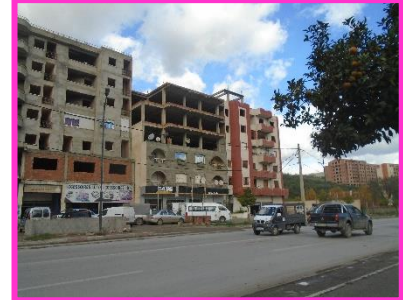
Fig. I. 62 : Immeuble collectif en construction au Nord, R+6
