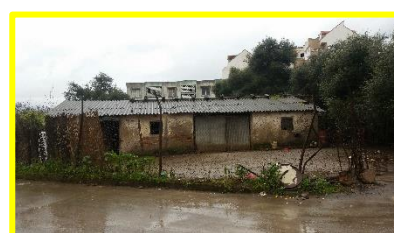
Fig. I. 66 : Atelier de plein pied au Sud
