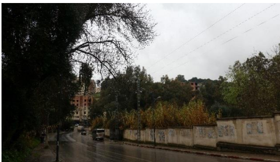
Fig. I. 55 : Végétation Dense et obstacles visuels présents du côté Nord.
