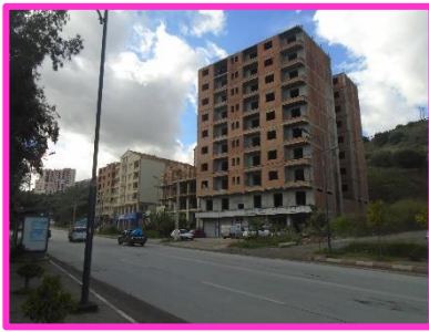
Fig. I. 60 : Immeuble collectif en construction au Nord, R+9
