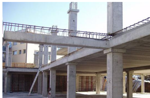
Fig. III. 29 : Structure en béton armé Source : https://www.notionsstructures.be/
