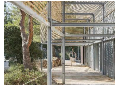
Fig. II. 54: Vue sur le treille de l'extension, ENSA-M. Source : Idem
