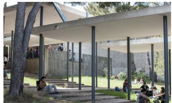
Fig. II. 58: Vue sur la coursive extérieure, ENSA-M. Source : Idem
