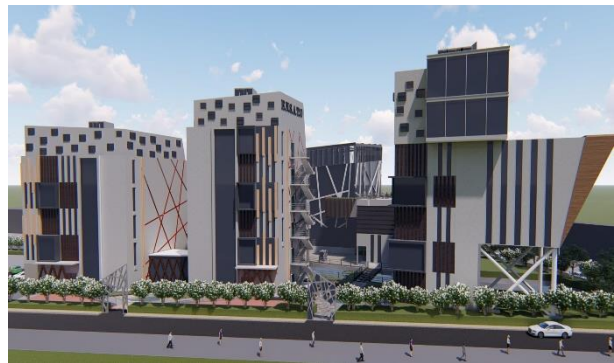
Fig. III. 28 : Vue sur la façade urbaine du côté Nord. Source : Auteurs.
