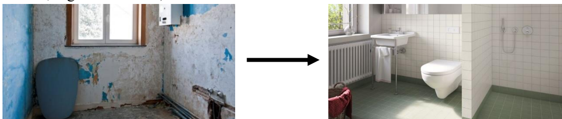
Fig. II. 1: Salle d'eau d'un HLM réhabilité, Bruxelles, Belgique. Avant/Après. Source : https://immobilier.lefigaro.fr – Velux France
