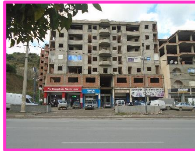
Fig. I. 61 : Immeuble collectif en construction au Nord, R+6
