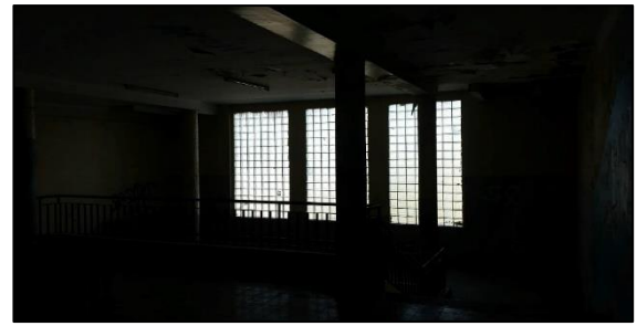
Fig. I. 81 : Faible éclairage du hall orienté Nord-Est. Source : Auteurs
