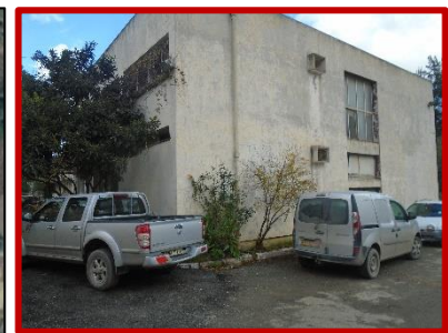
Fig. I. 63 : Subdivision des travaux publics de T-O, au Nord-Est, R+1
