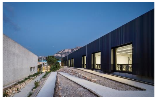
Fig. II. 59: Vue sur la façade Nord de l'extension. Source : Idem.
