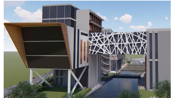
Fig. III. 74 : Utilisation du vitrage thermochromique au niveau de l'entité doctorat Source : Auteurs.
