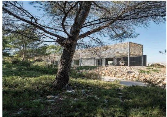
Fig. II. 57: Vue sur l'extension de l'ENSA-M. Source : PAN Architecture.
