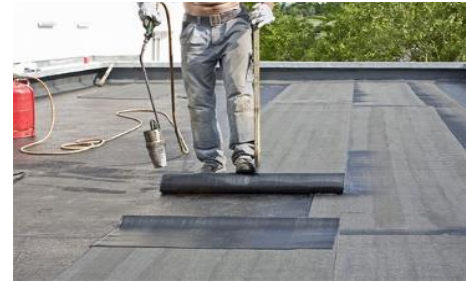
Fig. II. 3: Réfection de l'étanchéité d'une toiture terrasse.
