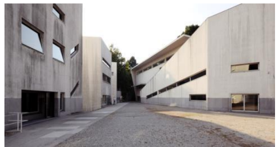
Fig. II. 73 : Vue sur le revêtement des parcours. Source: Alvaro_Siza.compressed.pdf
