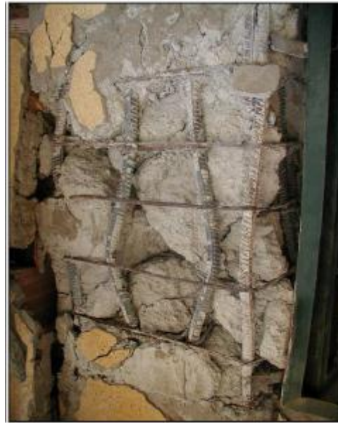
Figure I. 8 : écrasement de béton et flambement des aciers dans les deux poteaux de la cage d'escaliers.
