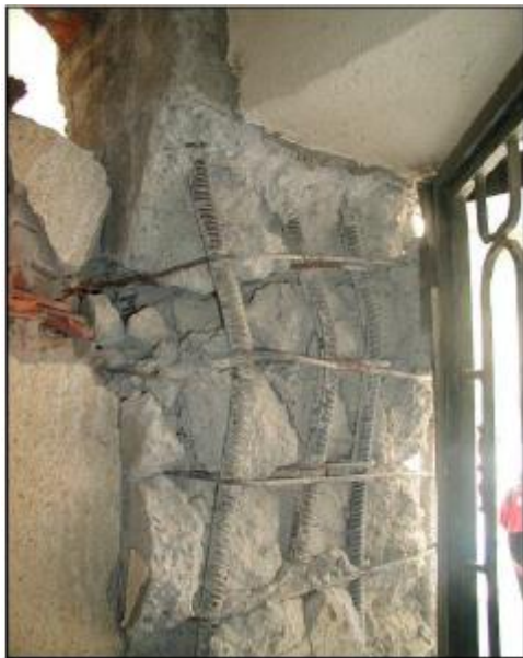
Figure I. 8 : écrasement de béton et flambement des aciers dans les deux poteaux de la cage d'escaliers.
