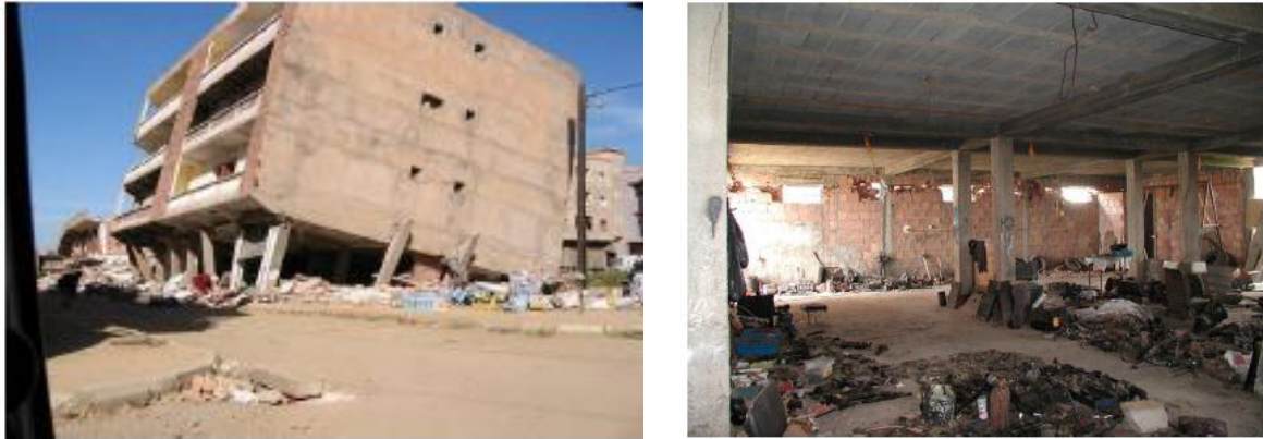
Figure I.13: Effondrement de la structure à cause d'un étage transparent (souple).
