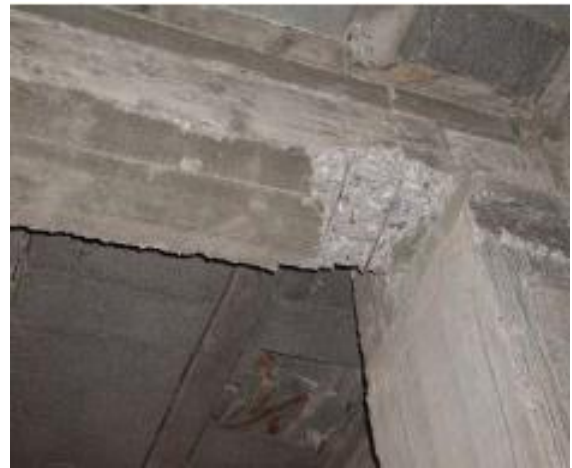
figure I.7 : Rotule plastique dans la poutre (comportement recherché)
