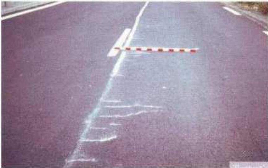
Figure I.8 : Remontée des fines, dégradation franche, significative et étendue. (LCPC, 1998)
