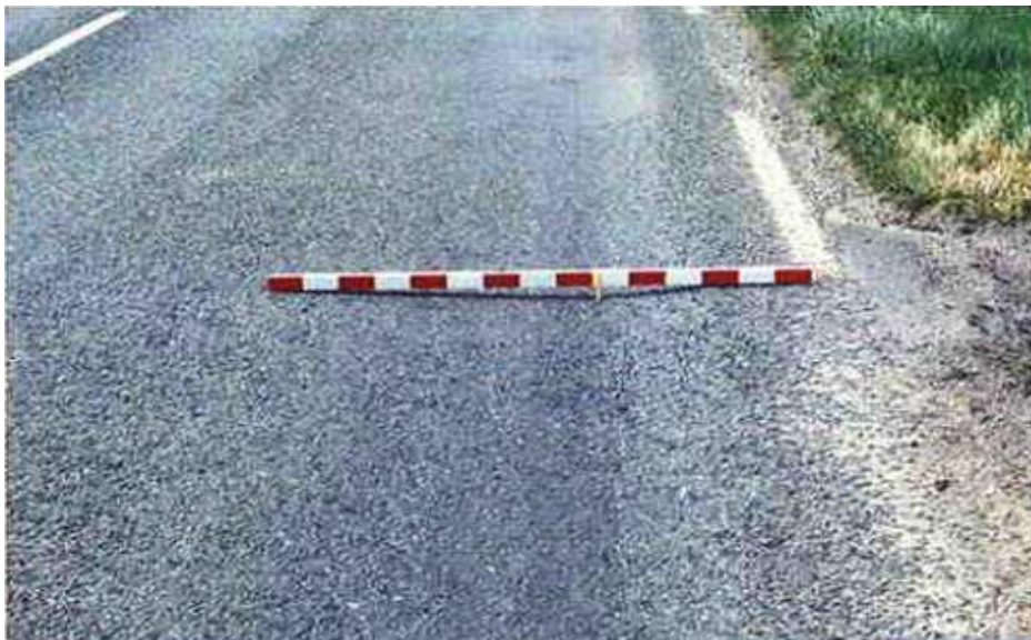
Figure I.9 : Dégradations de déformation (orniérage). (LCPC, 1998)
