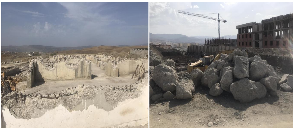
Figure II.7 : Débris de béton issus de déconstruction.
