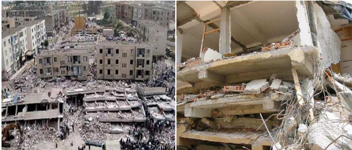
Figure II.6 : Le séisme de Boumerdes, 21 mai 2003.
