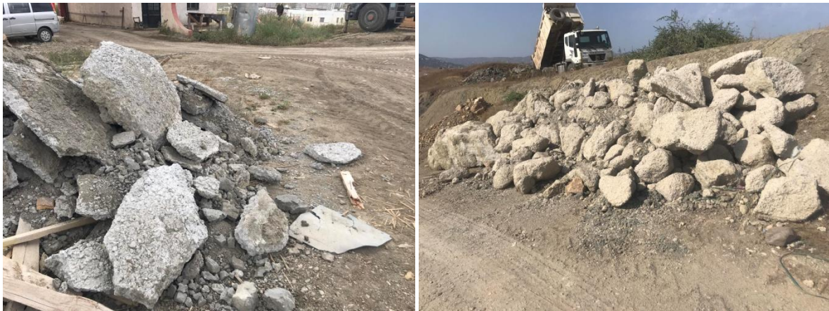
Figure III.18: Débris de béton sur chantier à Tamda.
