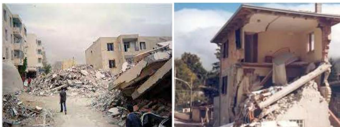
Figure II.5 : Le séisme d'El Asnam, survenu le 10 octobre 1980.
