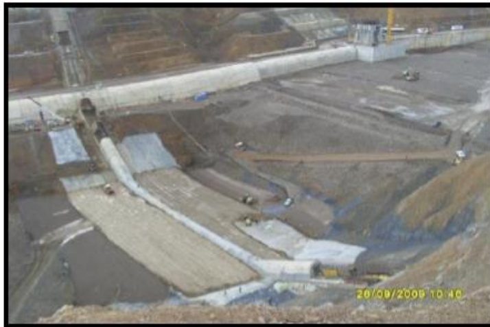
Figure III.3. Stabilisation par compactage de surface. (Cas d'une digue de barrage en terre de Kef-Eddir construit à Tipaza, 2009)
