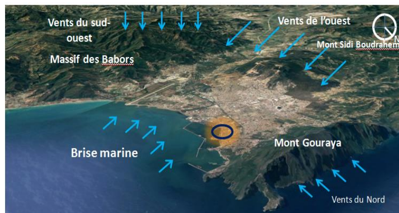
Figure 51 Carte illustrant la protection naturelle des vents du site d'intervention. Source Google Earth /Auteurs.
