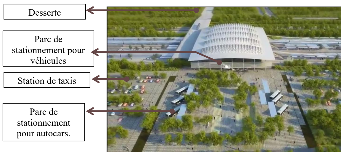
Figure 83 Espaces de services extérieurs de la gare.
