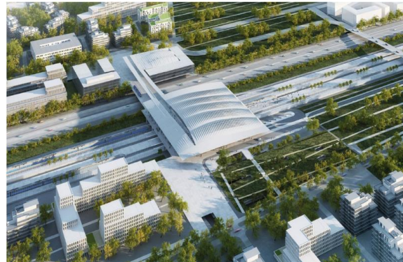
Figure 79 La nouvelle gare TGV «Montpellier Sud de France».
