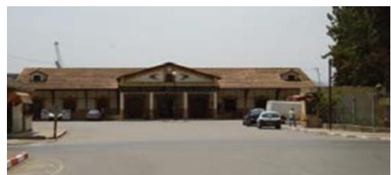
Figure 16 Gare ferroviaire de Bejaia.
