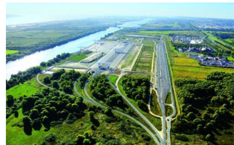
Figure 59 Terminal multimodal du Havre, source : France. http://www.usinenouvelle.com/article/la-plate-forme-multimodale-du-havre-dans-l-impasse.N371342
