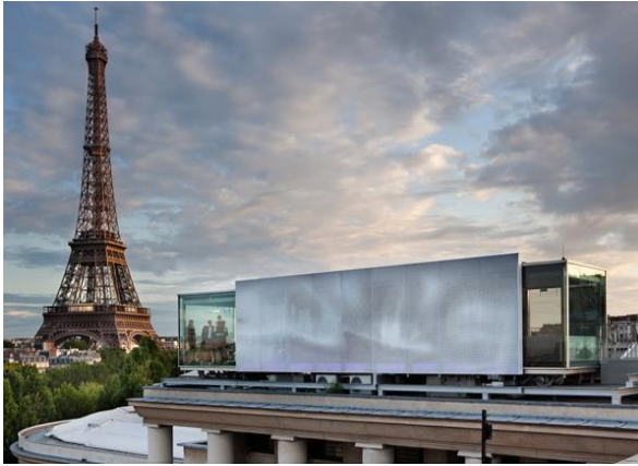
Figure 187 Exemple de bâtiment avec matériaux a changement de phase https://www.dezeen.com/2009/09/11/nomiya-temporary-restaurant-by-pascal-grasso/
