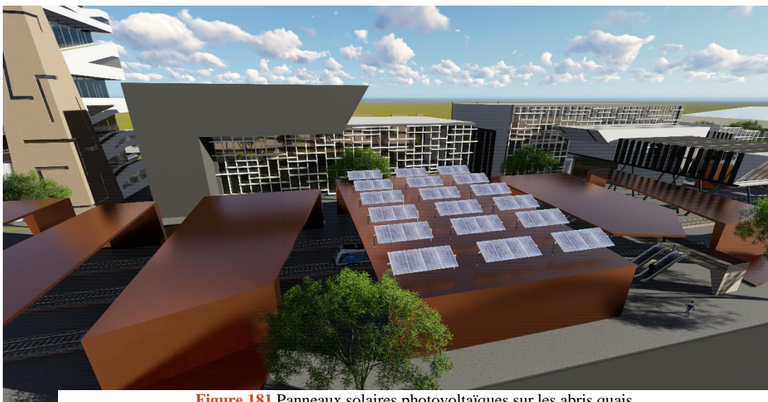
Figure 181 Panneaux solaires photovoltaïques sur les abris quais
