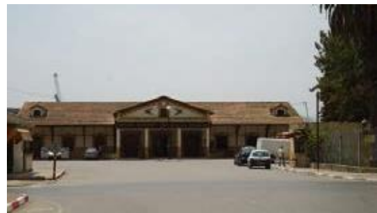
Figure 44 Gare ferroviaire de Bejaia.
