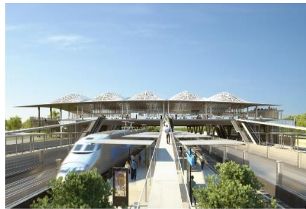
Figure 81 La nouvelle gare TGV «Montpellier Sud de France».
