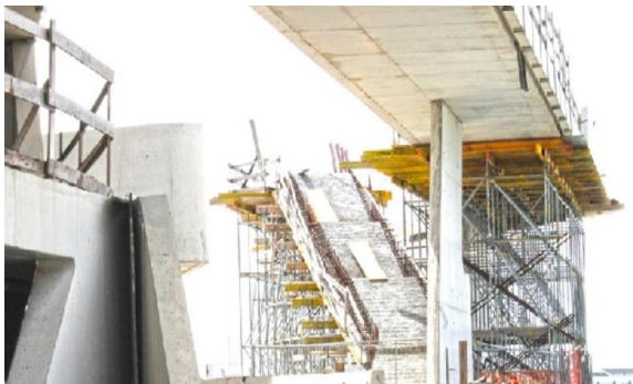
Figure 118 Tours d'étalement. Source : Site internet www.archdaily.com
