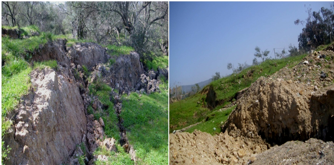
Figure IV.8. Glissement de terrain au niveau de la région d'azazga
