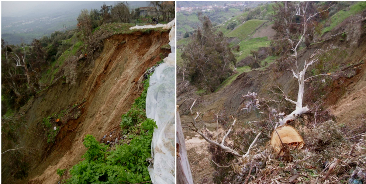
Figure IV.10. Glissement de terrain au niveau de la région de Tala N'Tgana
