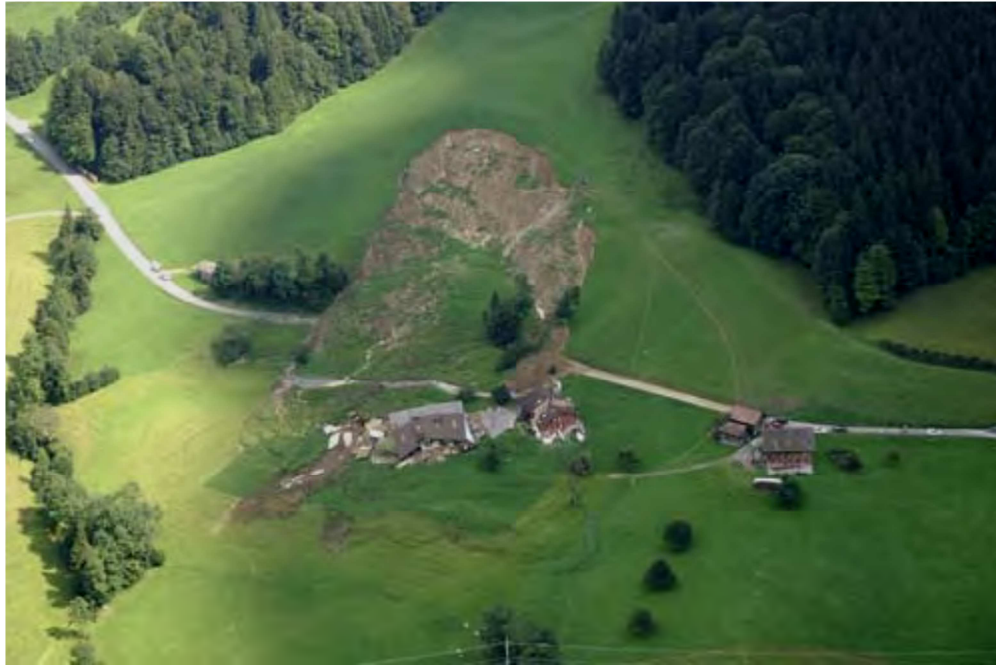
Figure I.9. Glissement de terrain à Feldweid (MAGALIE LEVASSEUR 2009)
