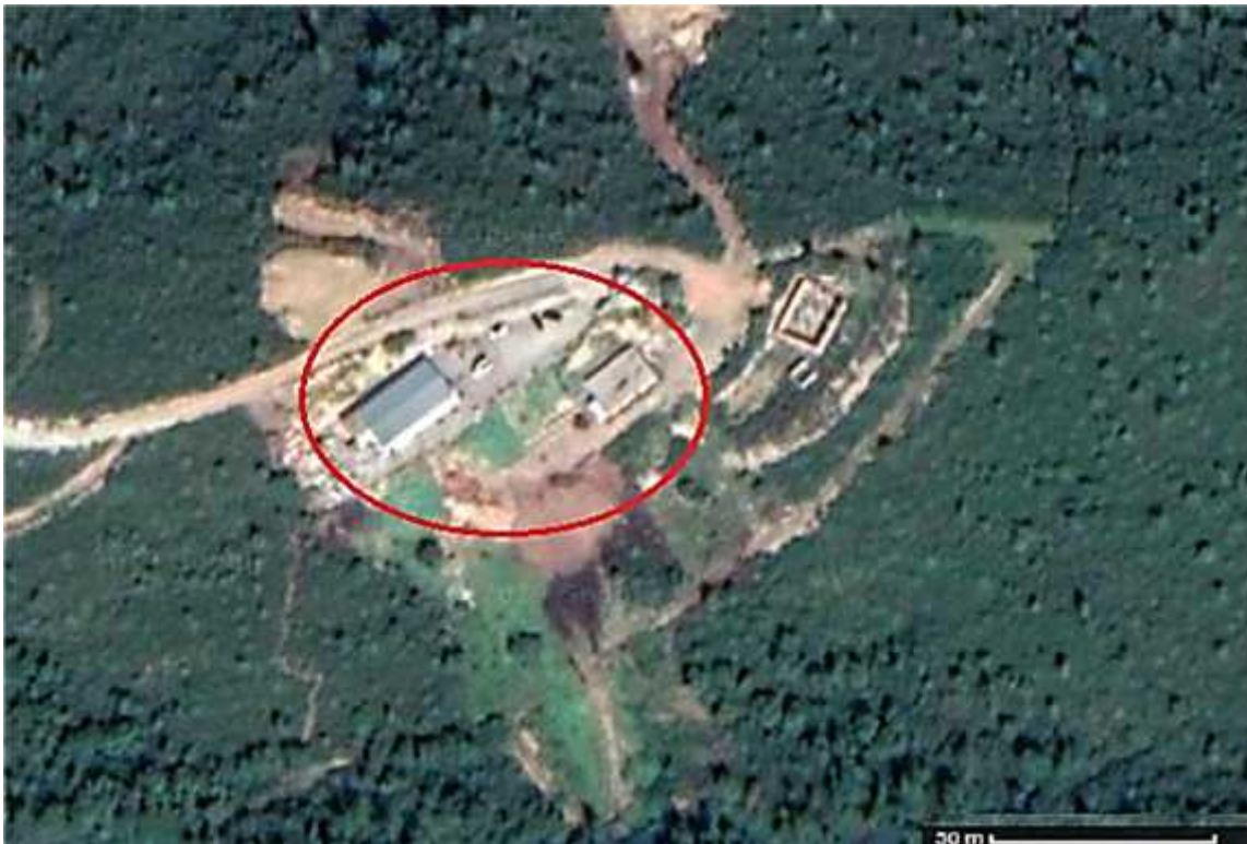
Figure 3 : Vue aérienne de l'huilerie « Amrioui » à Ait Yahia Moussa (Google Maps, 2019).
