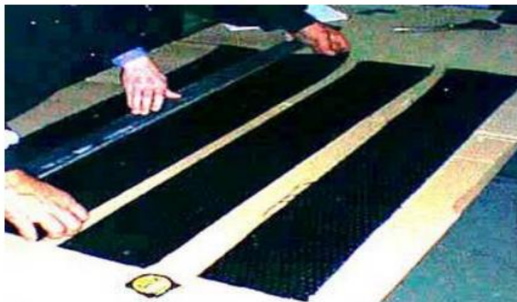
2. Découpage du tissu en fibre de carbone
