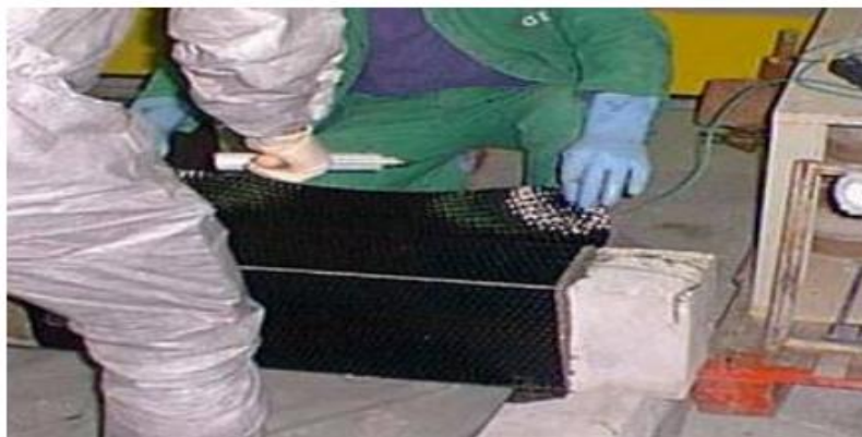
6. Marouflage : dégagement des bulles d'air Sur avec un rouleau
