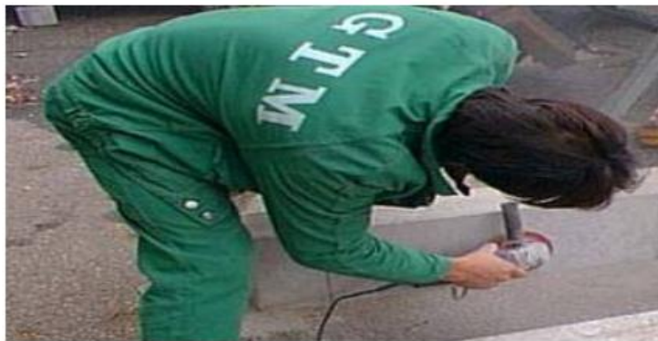
1. Ponçage de la surface du support béton
