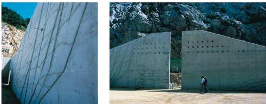
**Figure III.3 : Les BAP se caractérisent par leur fluidité, un faible ressuage, leur pompabilité ainsi qu'un bon maintien de leur ouvrabilité [32]**
