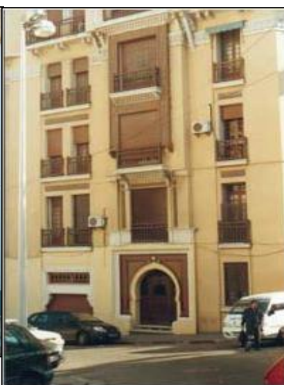
Fig. 23 : Porte d'entrée de l'immeuble rue Roosevelt.
