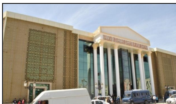
Fig. 39 : Le bâtiment après sa réhabilitation. Source : www.google.fr, les bâtiments de maison Citroën en Algérie.
