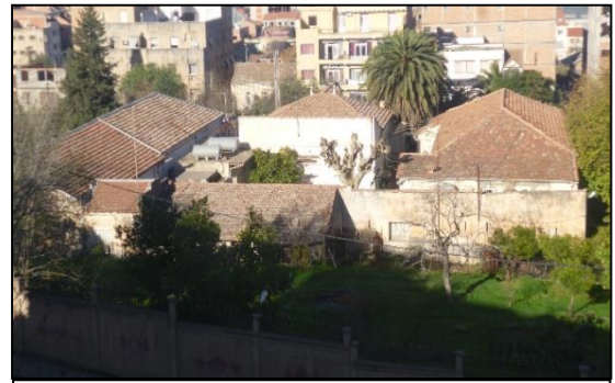
Fig. 83 : vue d'ensemble sur l'ex-daïra. Source : auteurs
