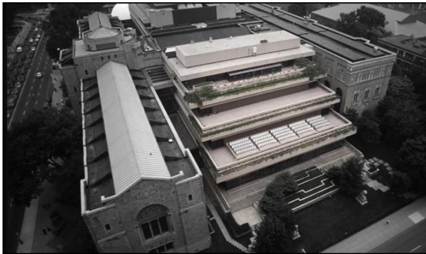
Fig.87 : Les terrasses, la partie détruite du bâtiment.
