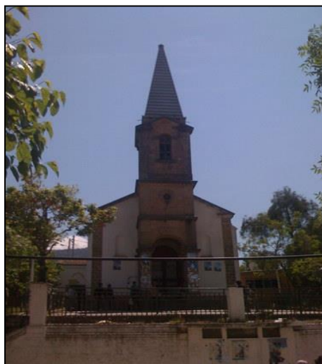
Fig. 36 : Eglise d'Azazga (actuellement) en état d'abandon. Source: auteurs.
