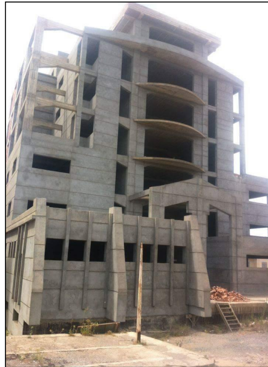
Fig.59 : nouvelle mairie en phase de chantier Source : auteurs
