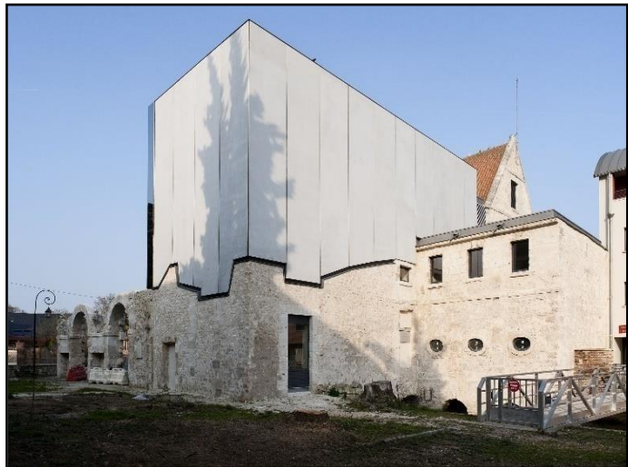
Fig. I.13 : Panneaux de béton préfabriqués posés sur le bâtiment existant.
