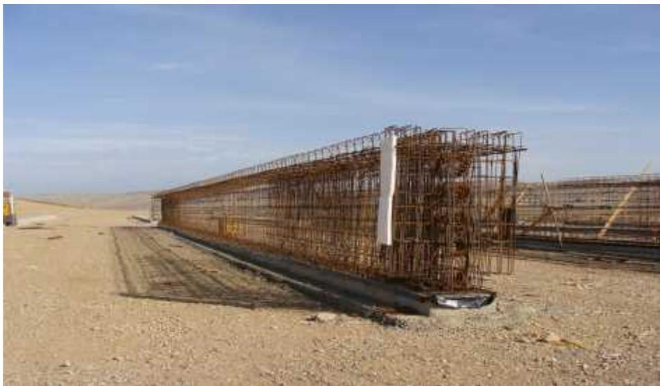
**Fig.1 : mise en place des armatures passives.**
