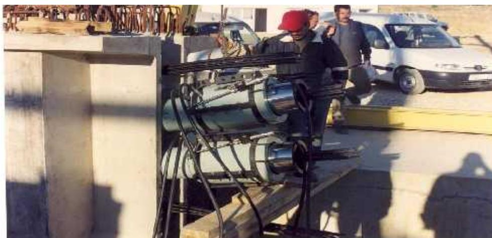
**Fig.9 : mise en tension du même côté simultanément.**
