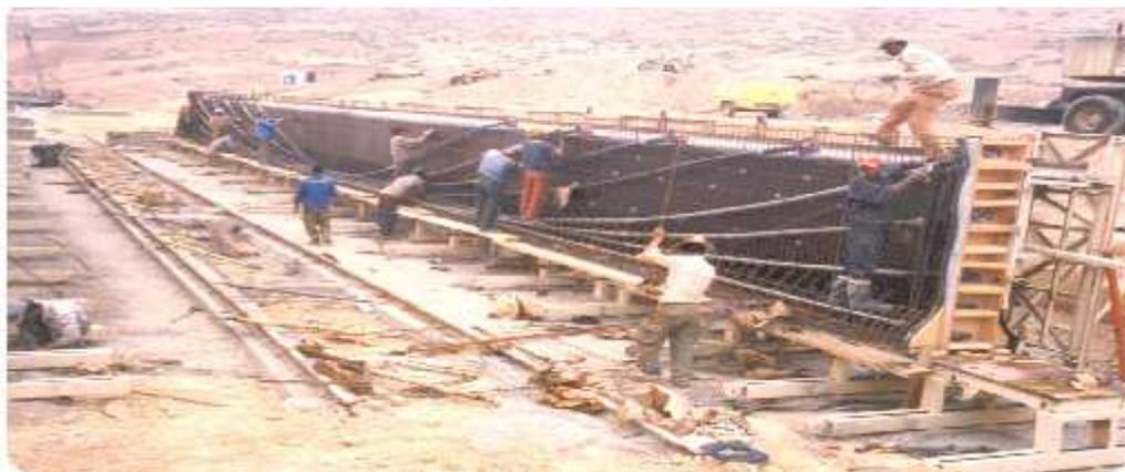
**Fig.3 : mise en place des gaines.**
