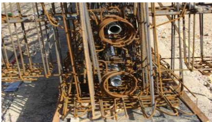
**Fig.5 : des frettages adjacents aux extrémités des gaines.**
