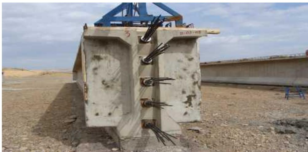
**Fig.8 : mise en place des organes d'ancrages.**
