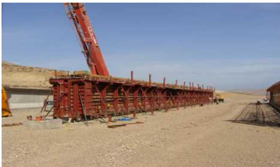
**Fig.2 : mise en place du coffrage.**
