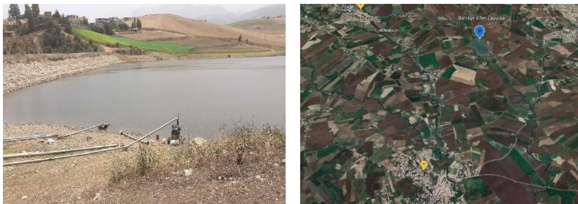
Figure 28. Barrage d'Ain Zaouia
