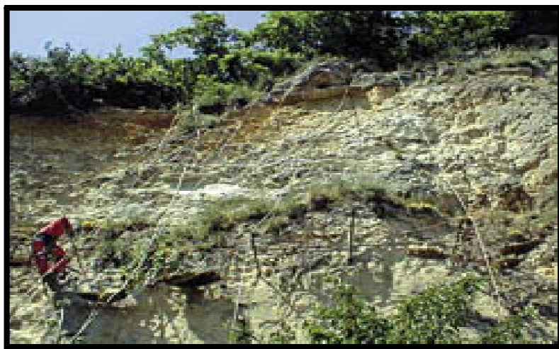
Fig. II.20: Pose d'écran de protection à mi- paroi
