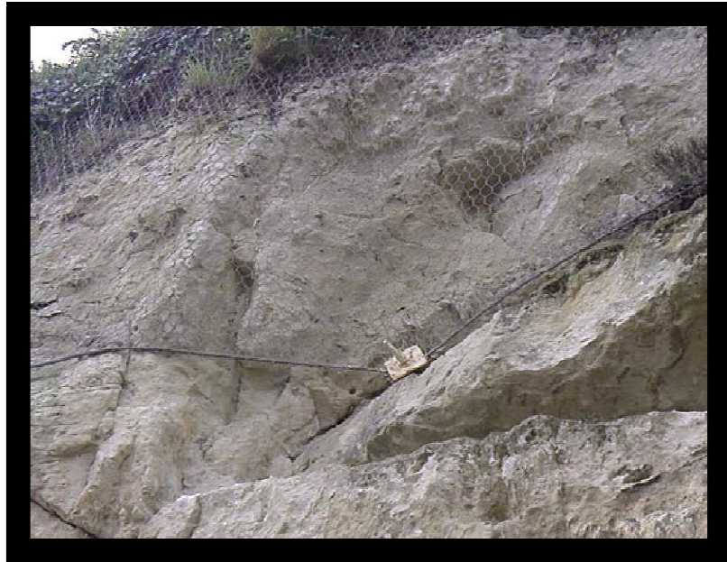
Fig. II.19: Grillage métallique plaqué
