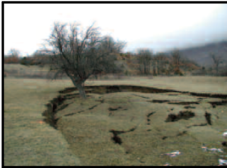
Fig. I.20: Niches d'arrachement, fissures et arbre Incliné
