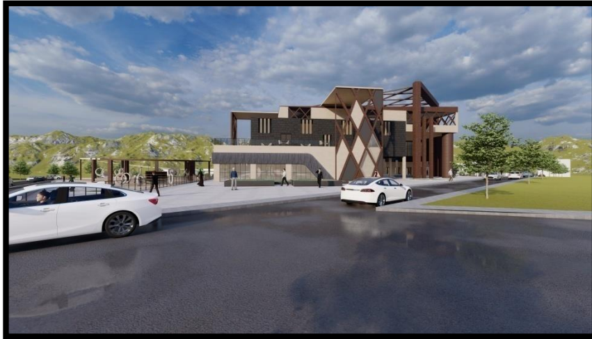
Photo 96. Façade Nord (contraste plein et vide )
