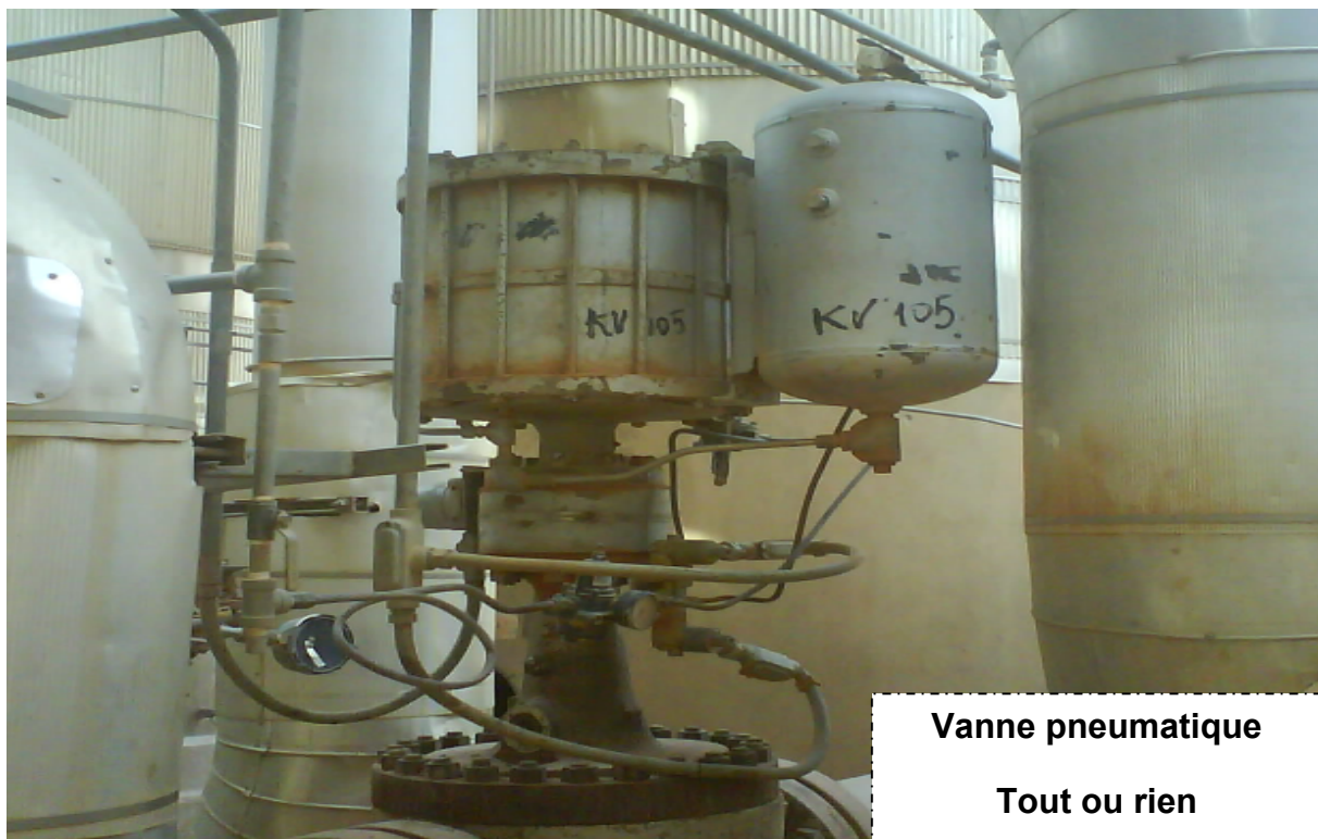
Fig2.15 : photo d'une vanne pneumatique tout ou rien.
