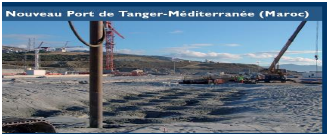
Figure I.9 : Exemple de vibrocompactage.
