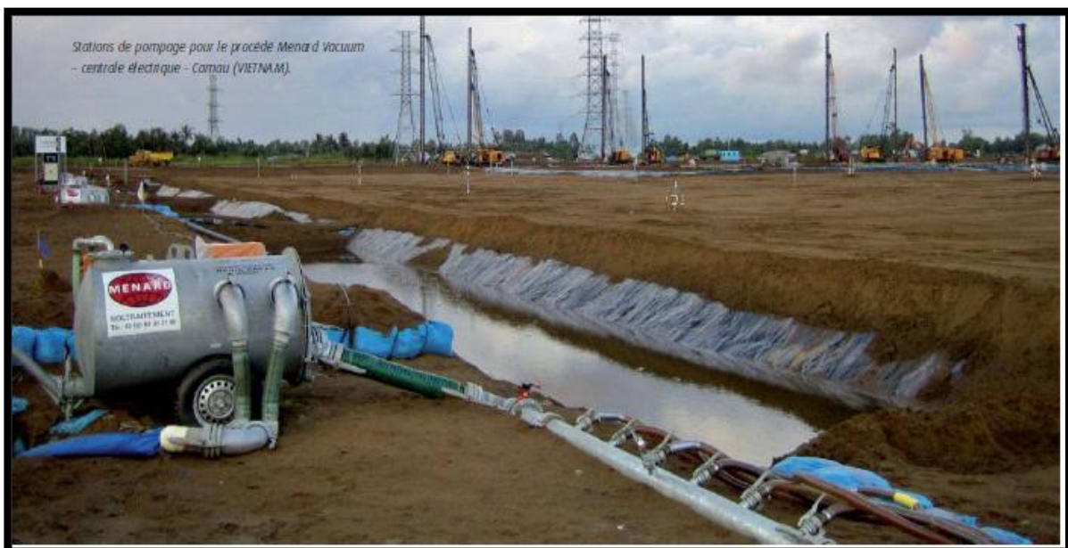
Figure I.5 : Principe de la consolidation atmosphère (MENRAD)
