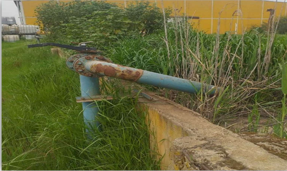
Figure 36 : Sortie du rejet liquide de la station de neutralisation (Originelle, 2022)
