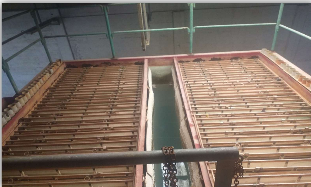
Figure 61 : Décantation lamellaire (Originelle, 2022)
