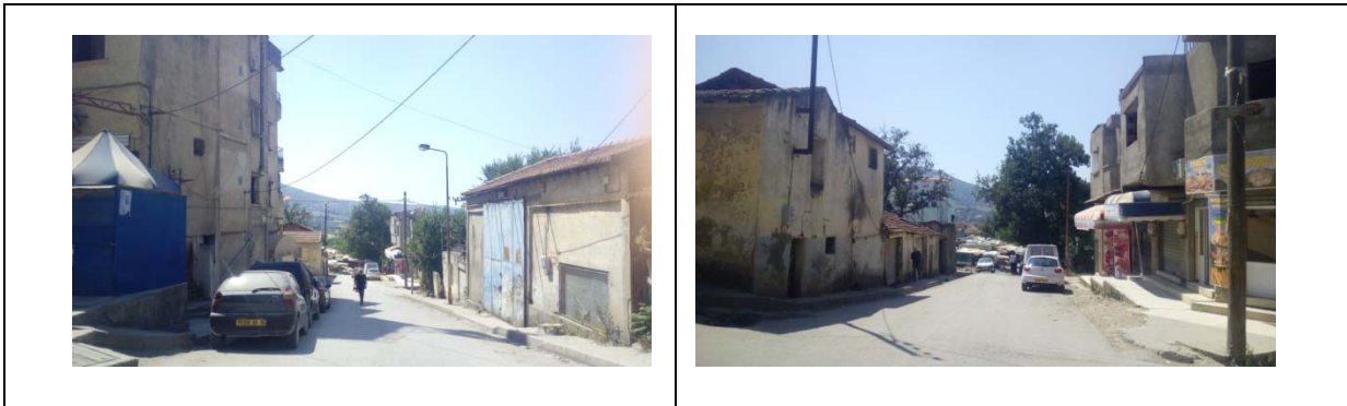
Figure159: Photo de la voie de Souq (Source : auteur)
