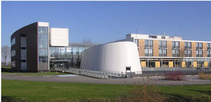
Figure 194 : Façade principale (Source : internet)
