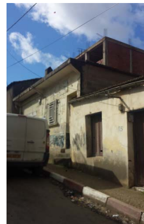
Figure 56: photo de Construction de gabarit R. (Source : auteur)
