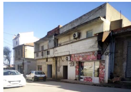
Figure 89:paroi 2. (Source : auteur)
