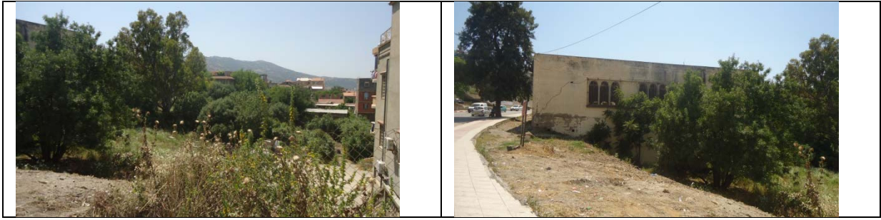
Figure171 : Photo de l'ex justice (Source : Auteur)
