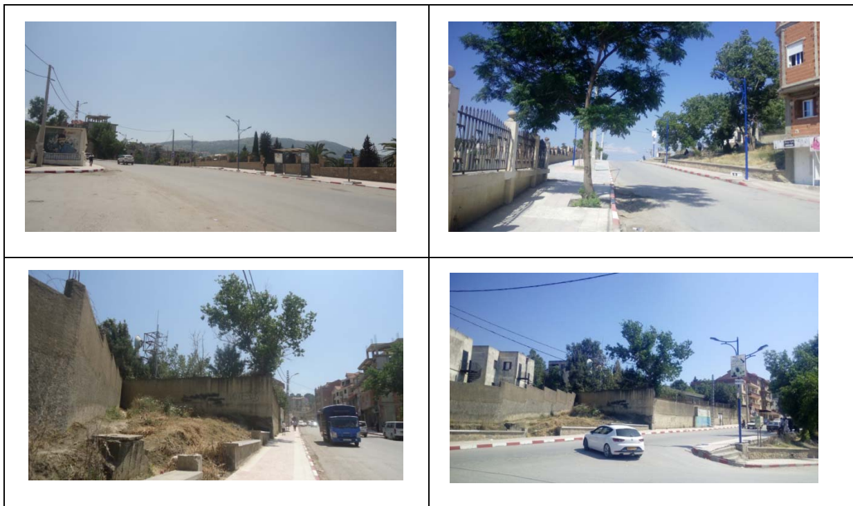
Figure146 : Photo de l'accès Nord (Source : auteur)
