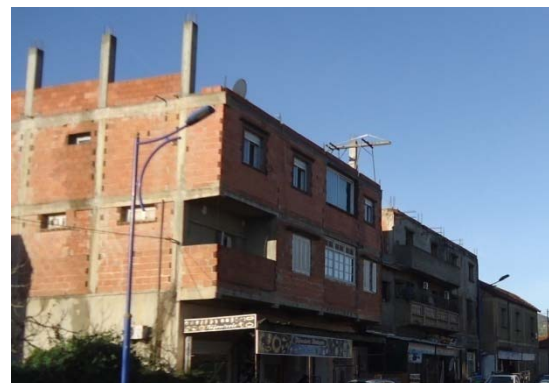
Figure41 : construction privé (Source : auteur)
