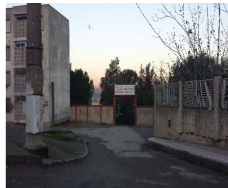
Figure71: Lycée hamdani Saïd (Source : auteur)
