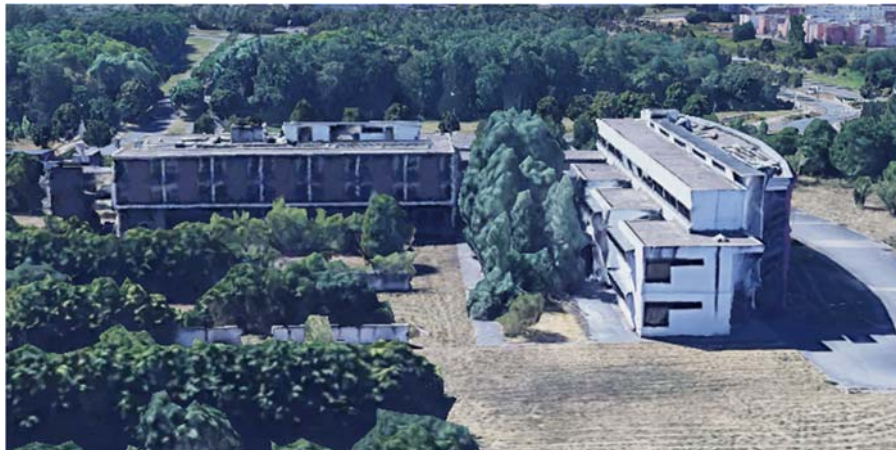
Figure 195 : Façade postérieure (Source : internet)
